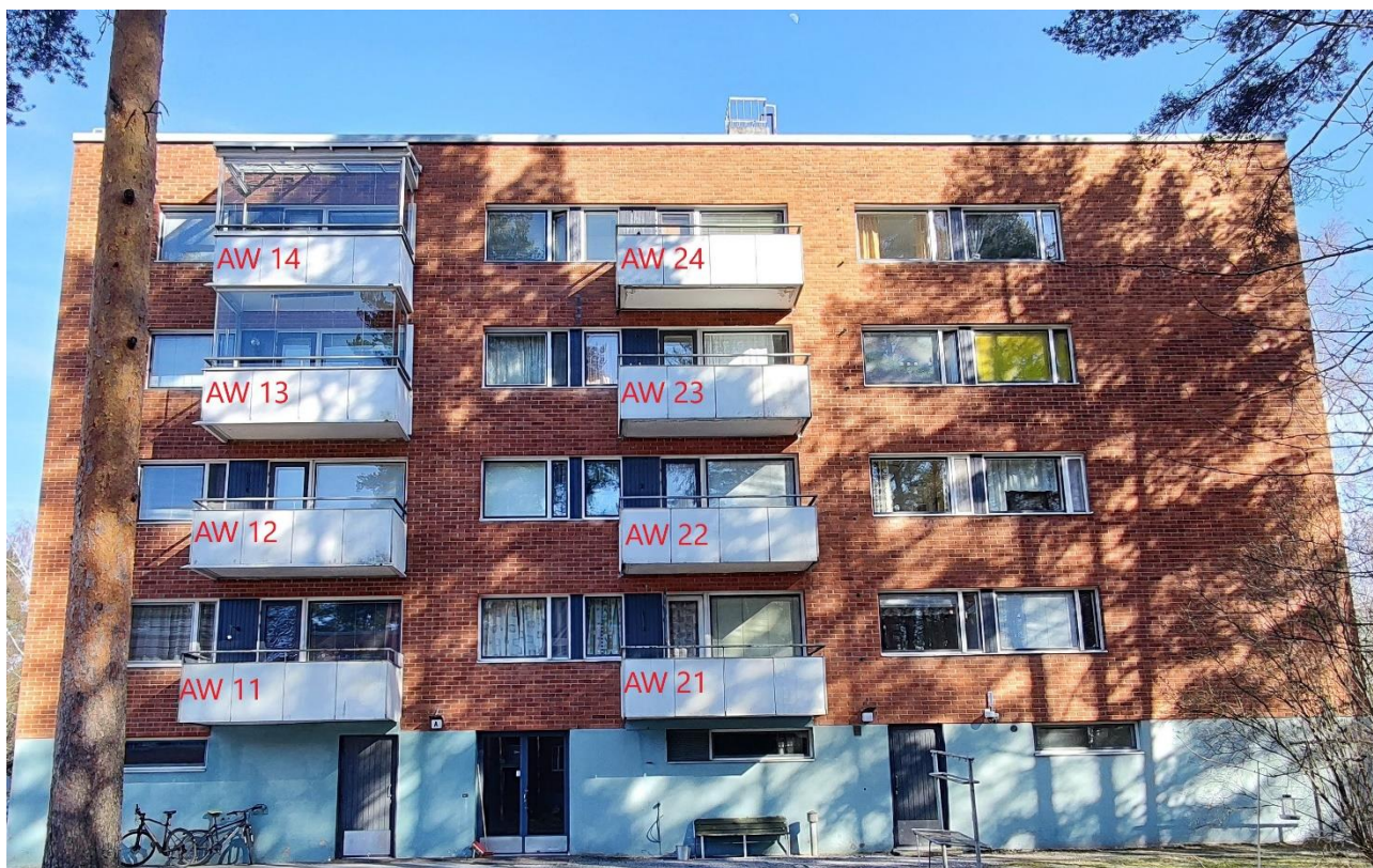
Kuva 12. A rakennus tutkimuskohdat länsipuolelta.
