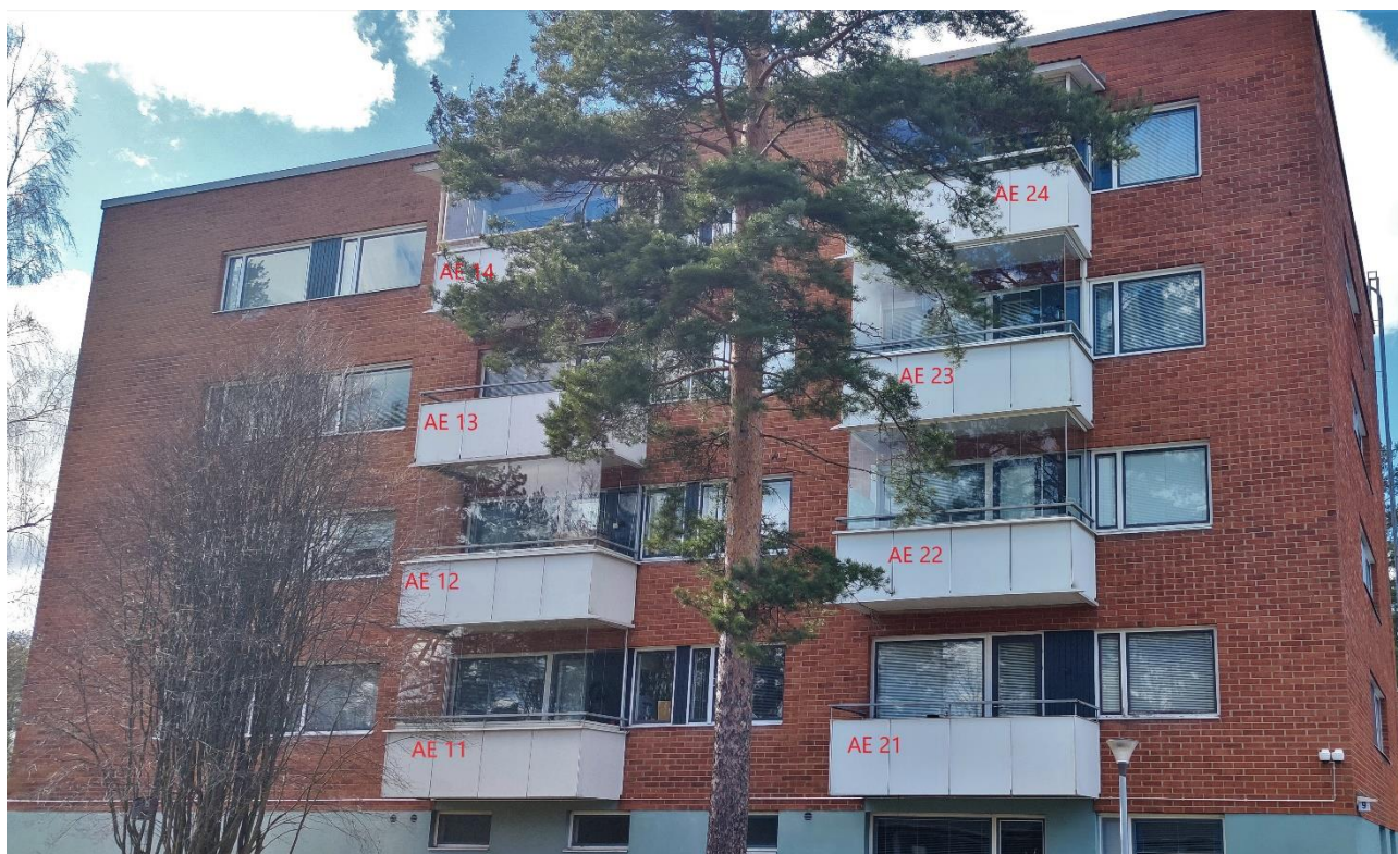
Kuva 14. A rakennuksen tutkimuskohdat idänpuolelta.
