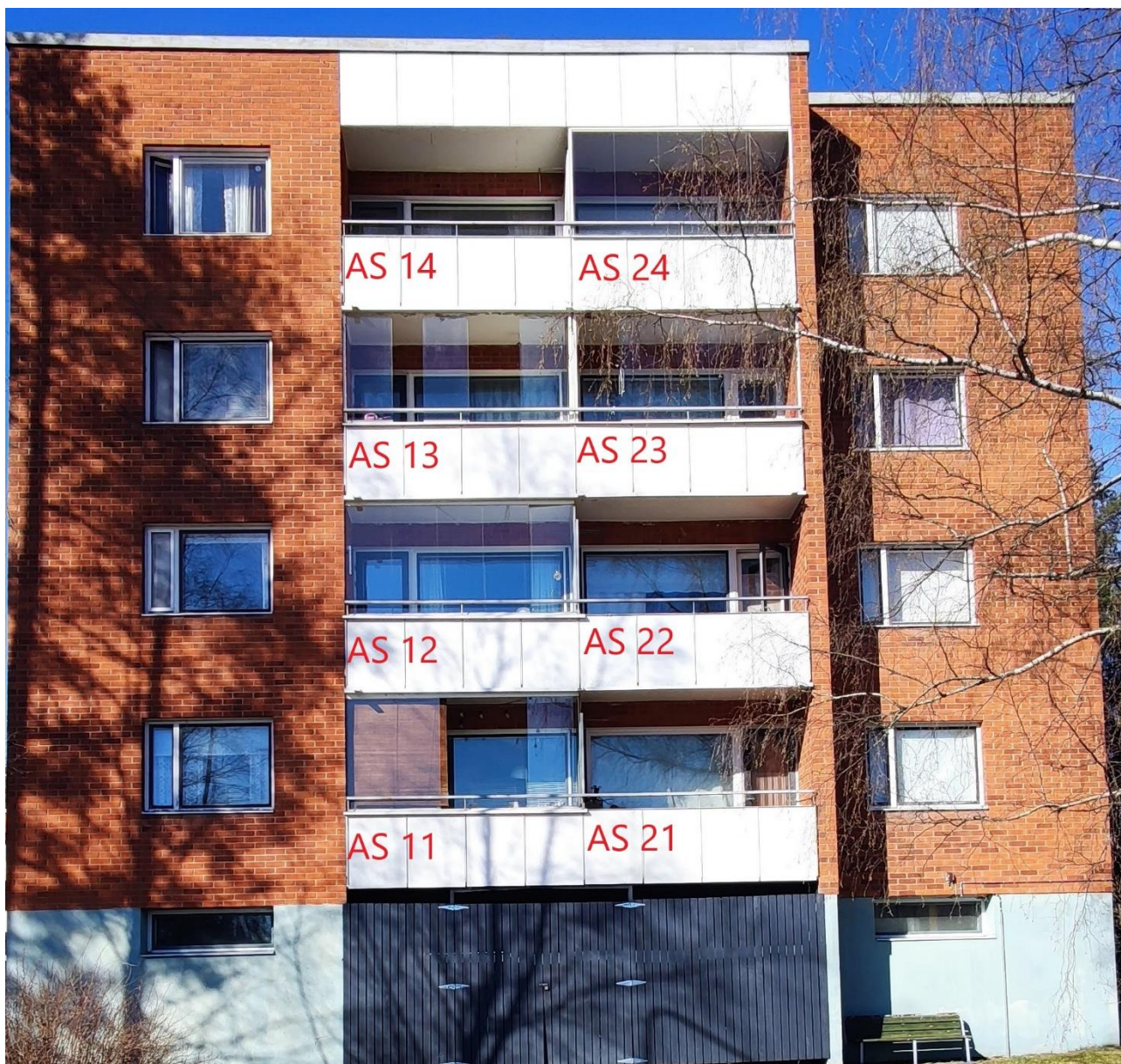
Kuva 13. A rakennus tutkimuskohdat eteläpuolelta.
