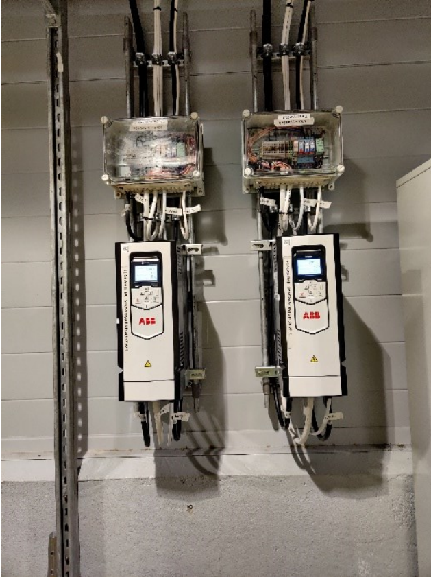
Kuvio 15. Taajuusmuuttajien ja kytkentäkoteloiden asennus
