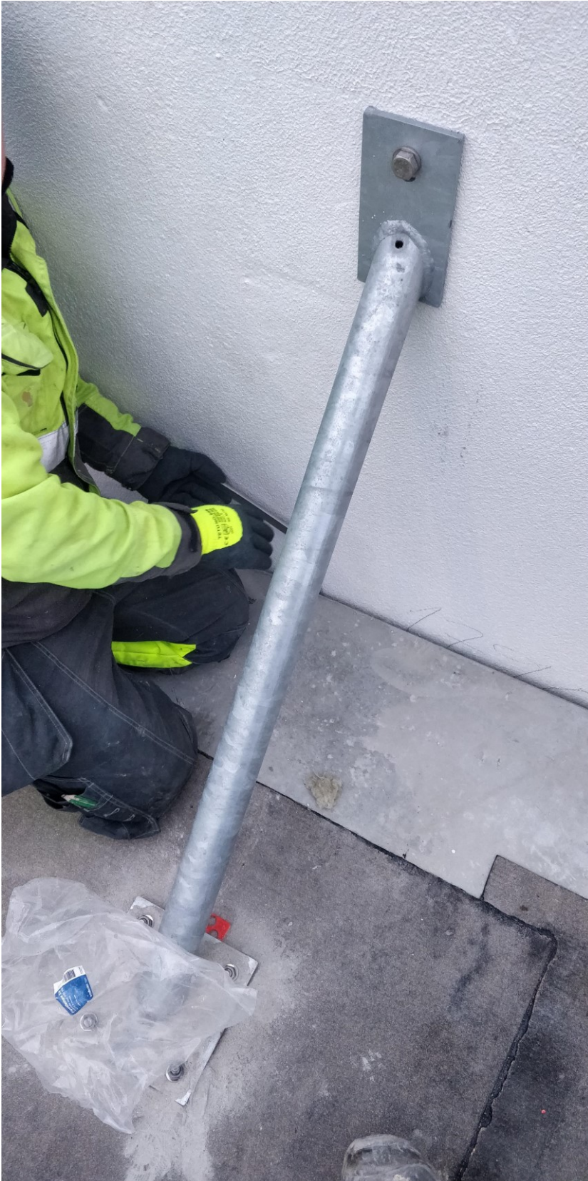
Kuva 16 Kuusiokantaruuvien kiristäminen käynnissä Tuulensuojan vesikatolla. Vesikatolle tulee P4X-kiinikeiden lisäksi vinotuet, koska vesikaton pautila tukeutuu parvekepiellelementteihin.
