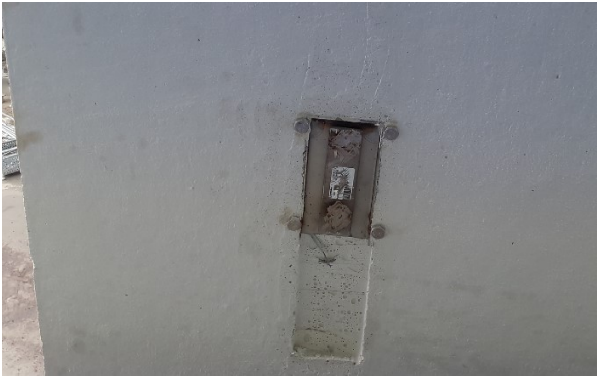
Kuva 19 Kaideosa, joka on valettu vinoon elementtitehtaalla.
