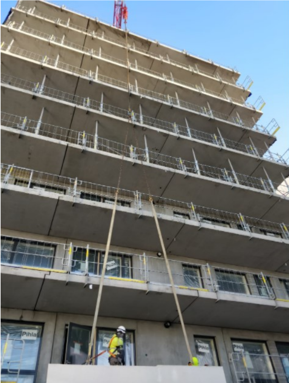
Kuva 10. Parvekepielielementtien asennus käynnissä pitkillä nostoketjuilla.
