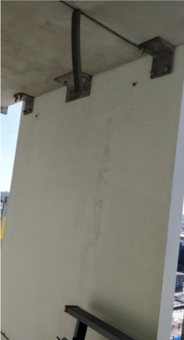
Kuva 17 Kuvassa näkyy pielitelementin kiinnitys kulmaraudoin. Elementti jouduttiin tukemaan elementtitiilla asennusaikana ennen kuin kulmaraudat olivat kiinnitetty. Kyseiset kulmaraudat jouduttiin vielä pellittämään ennen lopullista lopputulosta.
