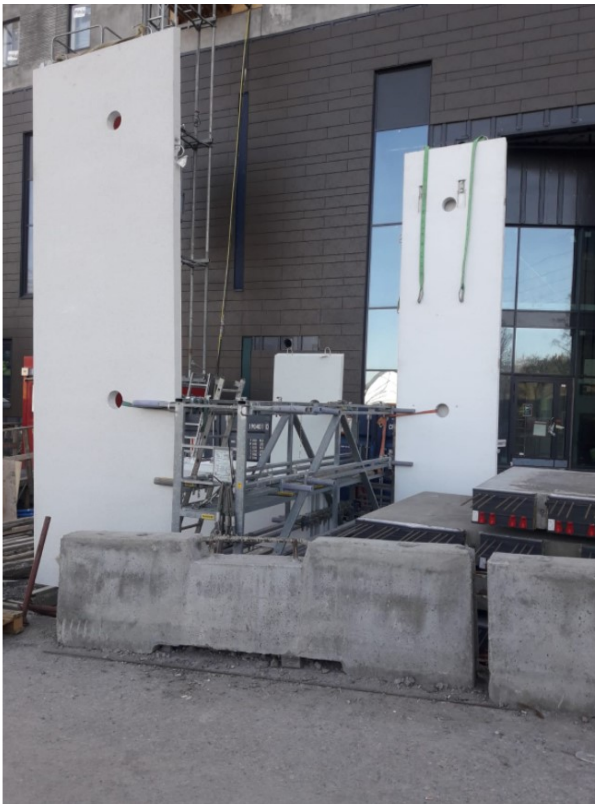
Kuva 5 Korkeat piellelementit ovat fakissa sidottuna kiinni. Kuvassa näkyy myös parvekelaattojen välivarastointi työmaalla.
