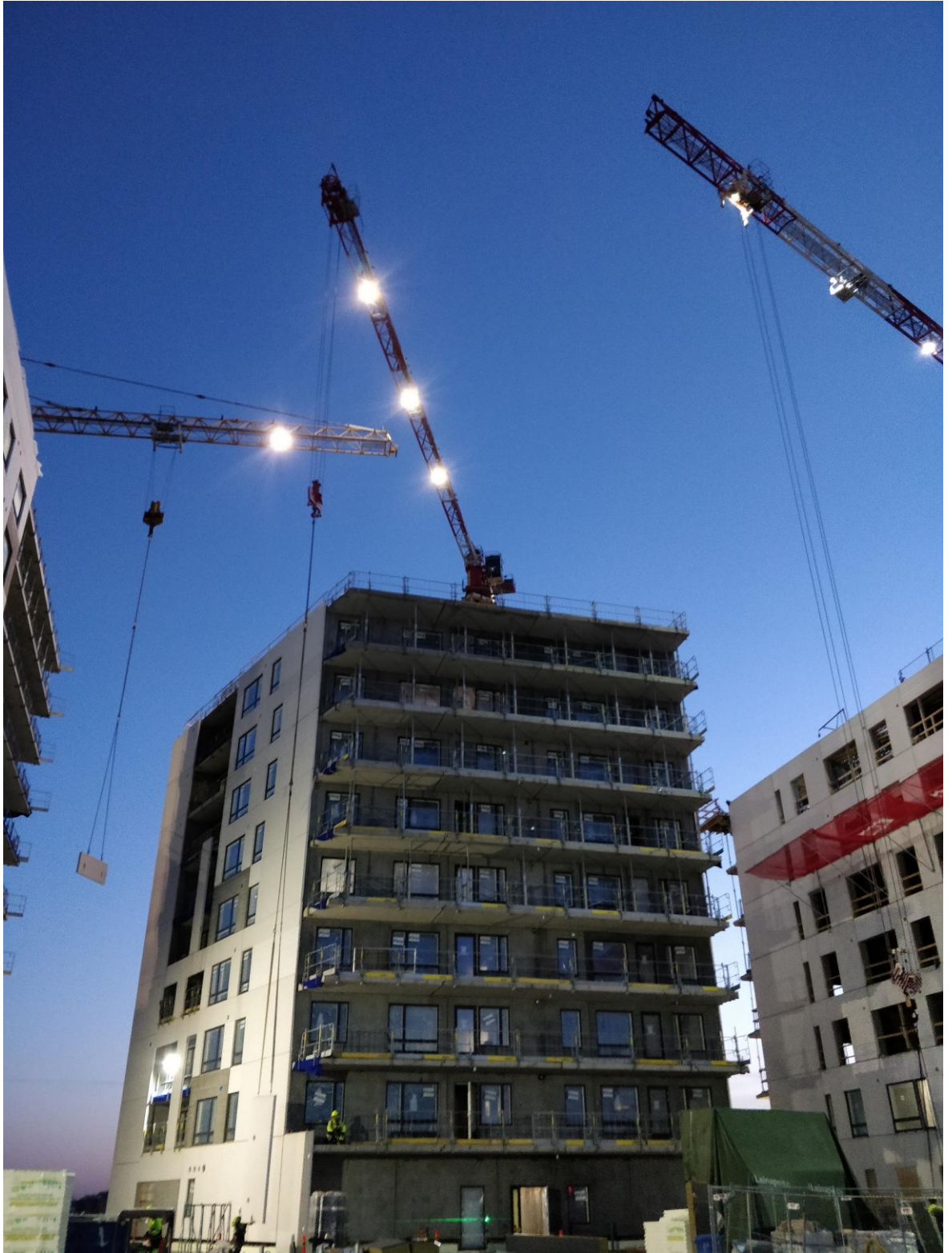
Kuva 9 Molemmissa taloissa pieliementtien asennus käynnissä. Pihakannella alamies valvomassa nostoja.
