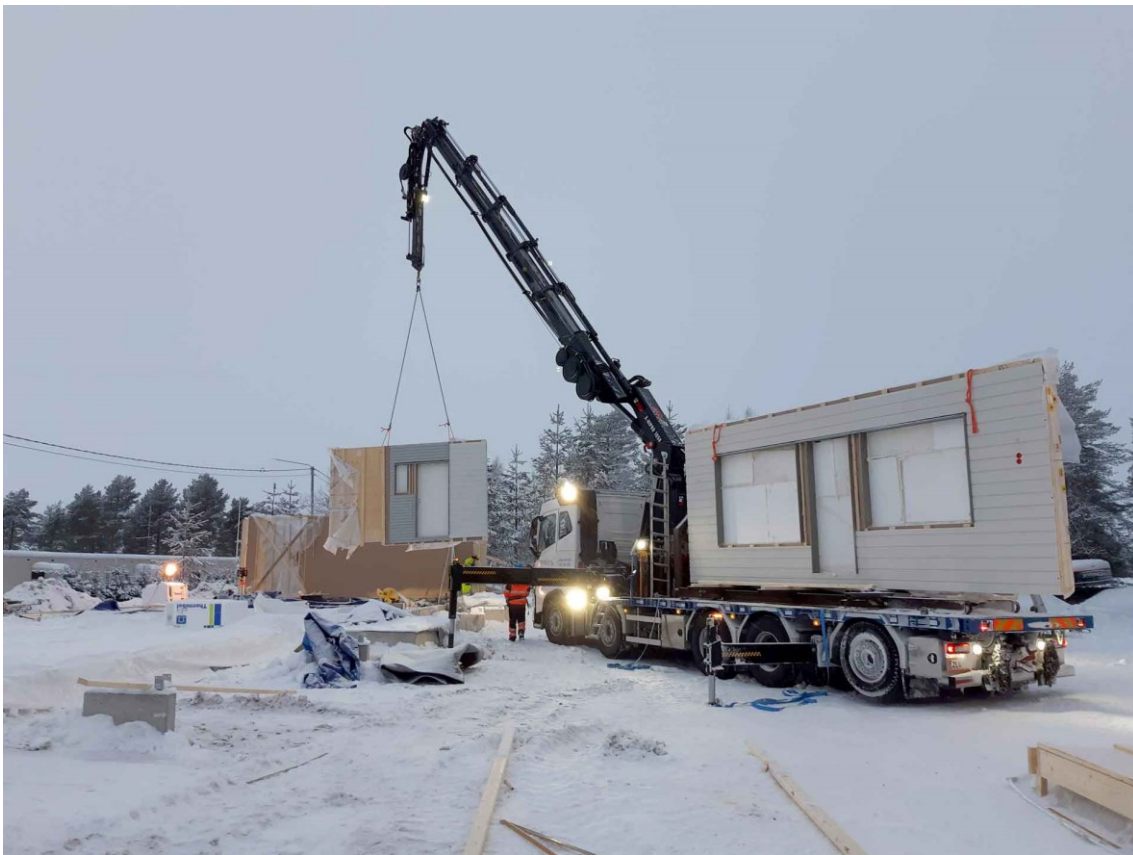
KUVA 2. Seinäelementtien asennus (12)
