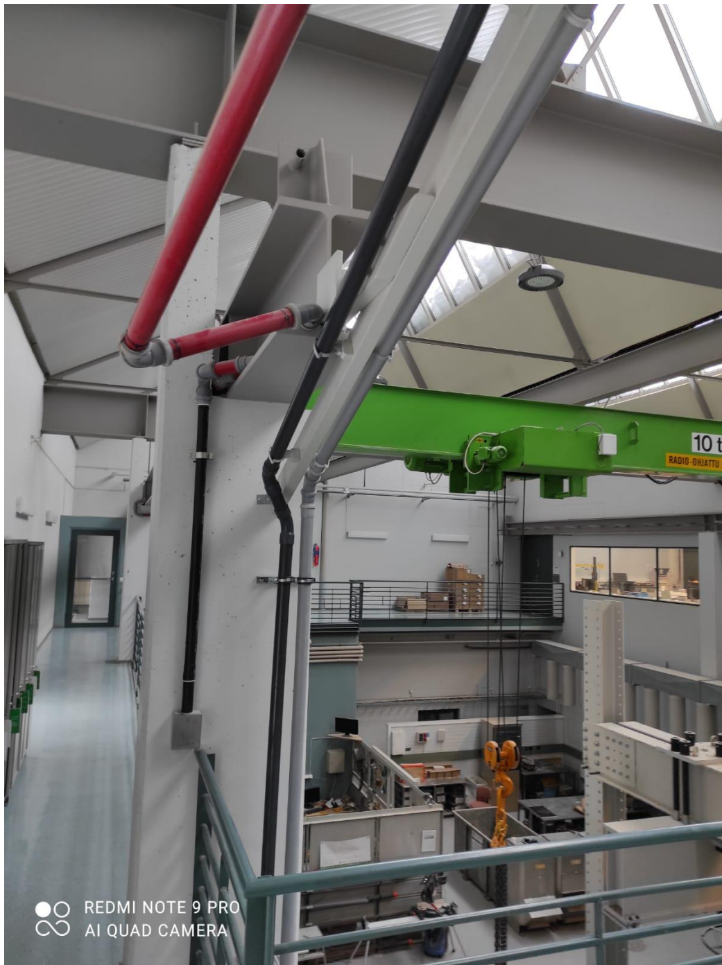
Kuvio 21. Putkiston ylempi osa.
