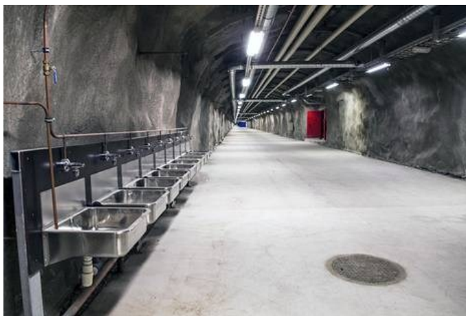
Kuva 2. Ruolahden alle 1970 luvulla rakennettu väestönsuoja
