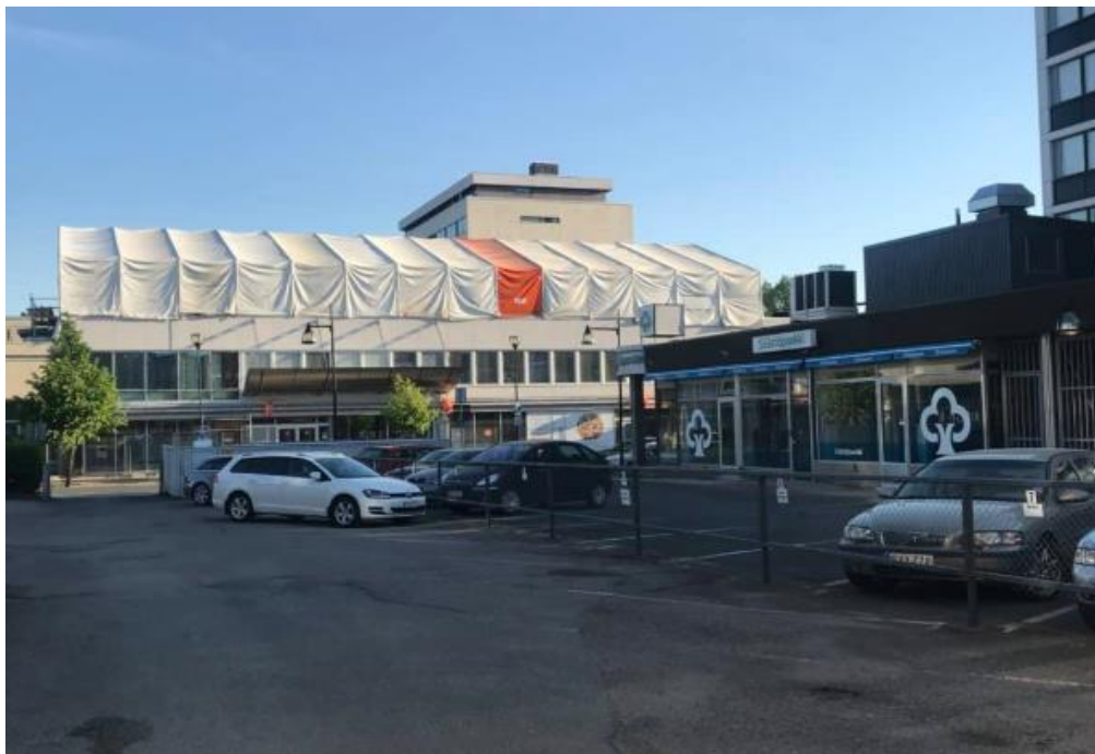
KUVA 3. Sääsuoja perustaminen vesikatolle (Telinekataja julkaisuaika tuntematon)
