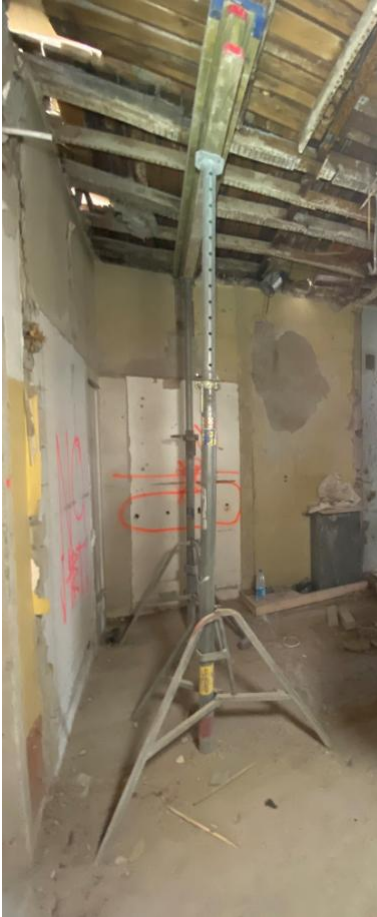
Kuva 17 Palkkien pystytuenta [kuva Ramboll Finland Oy]
