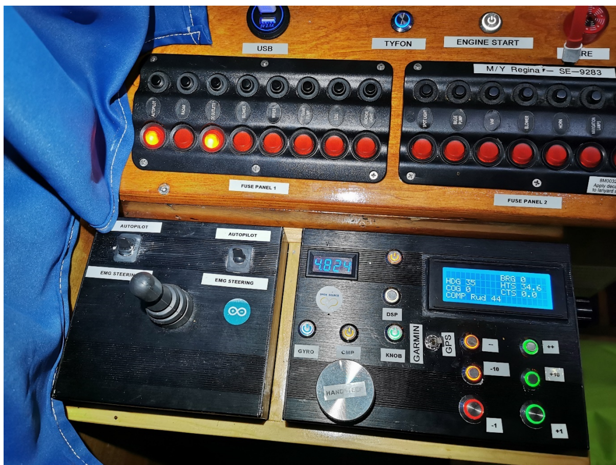
Figur 19. Den slutgiltiga installationen.
