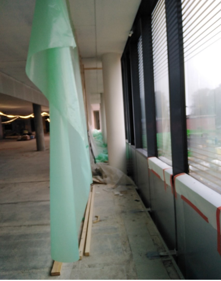
Kuva 9. Julkisivulasituksien ajaksi tehty muovinen suojaseinä purkuvaiheessa.
