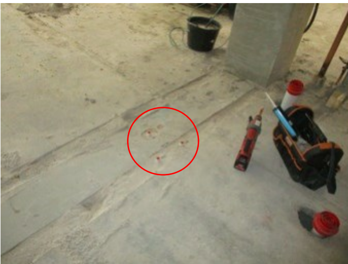
Kuva 8. Päällystettävyyssmittauksissa yksi mittapiste koostuu useammasta mittausreiästä.
