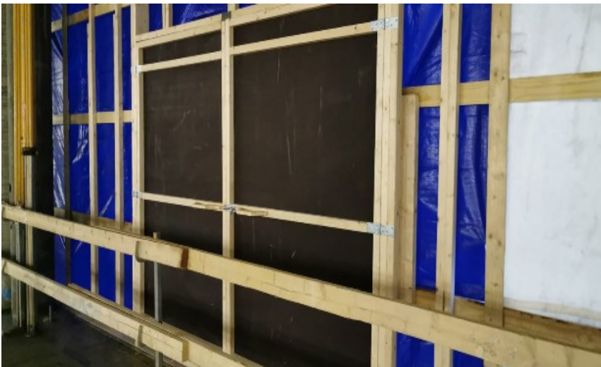
Kuva 15. Ulkoseinän suojapeiteseinän haalausaukko.
