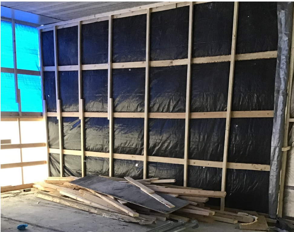
Kuva 13. Rakennuksen vaipan tiivistäminen mahdollisimman varhaisessa vaiheessa.
