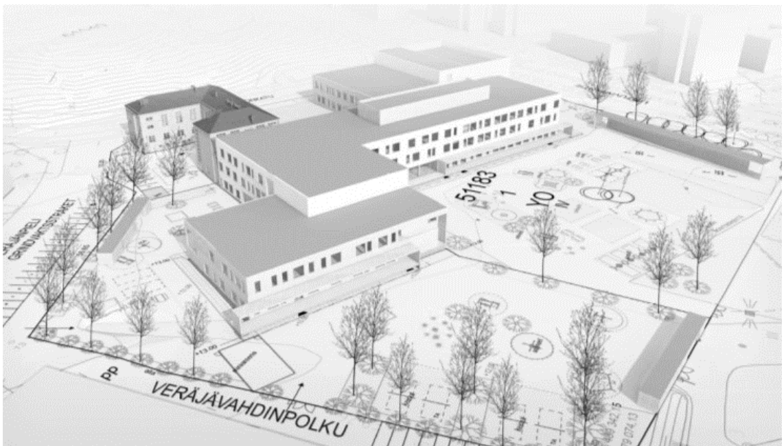
Kuva 1. SRV Rakennus Oy:n rakentama Monikon koulukeskus Espoon Leppävaarassa. 3
