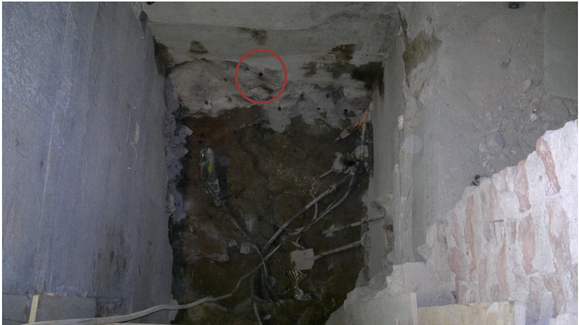
Kuva 11. Kallion varaan perustetun rakennuksen hissikuopan louhintaa. Tummat pisteet ovat kallion kestävyden varmistamiseksi asennettuja kallioankkureita.
