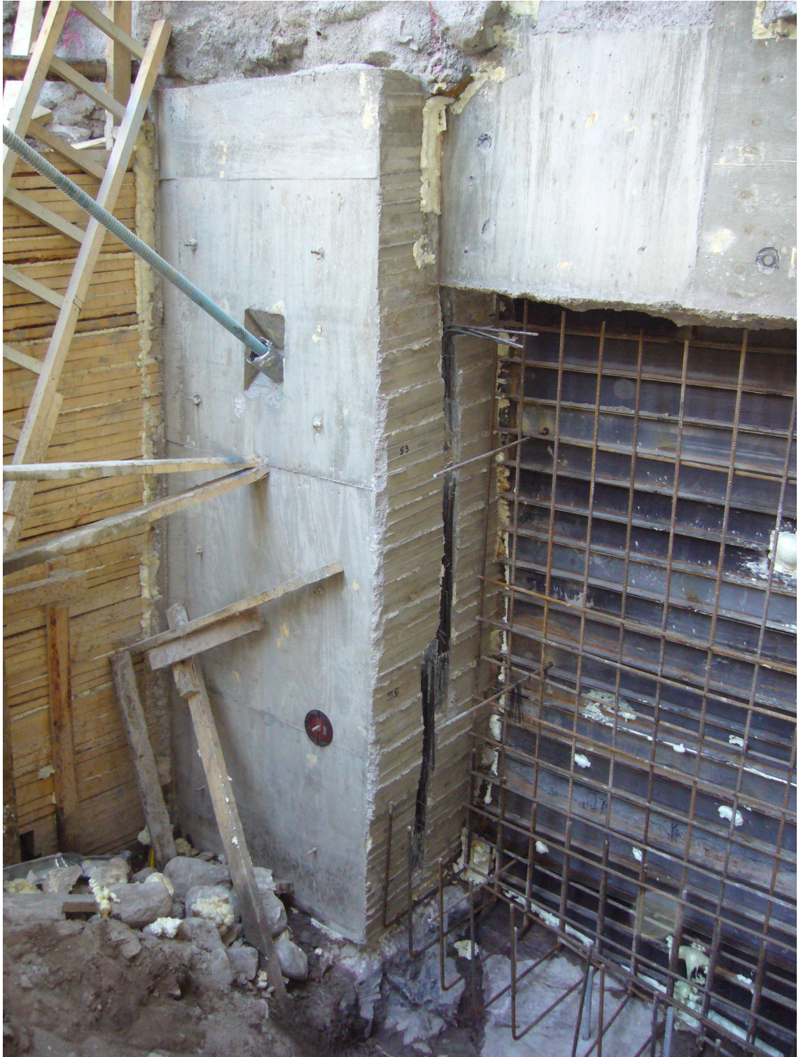
Kuva 12. Lamellointityö käynnissä. Vasemmalta katsoen kuvassa kaivannon seinä, valmis lamelli ja osittain raudoitettu lamelli. [4.]
