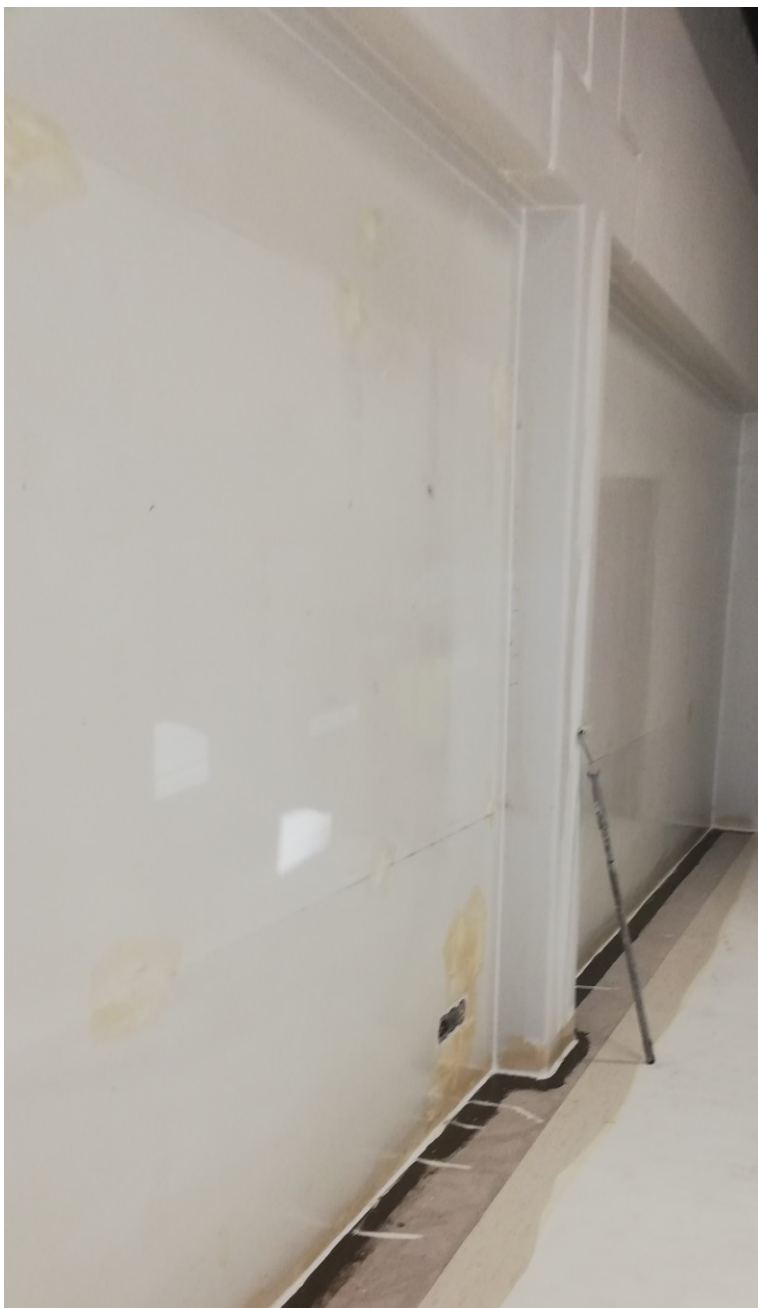
Kuva 6, TKR-asennus käynnissä. 1. kerros asennettu
