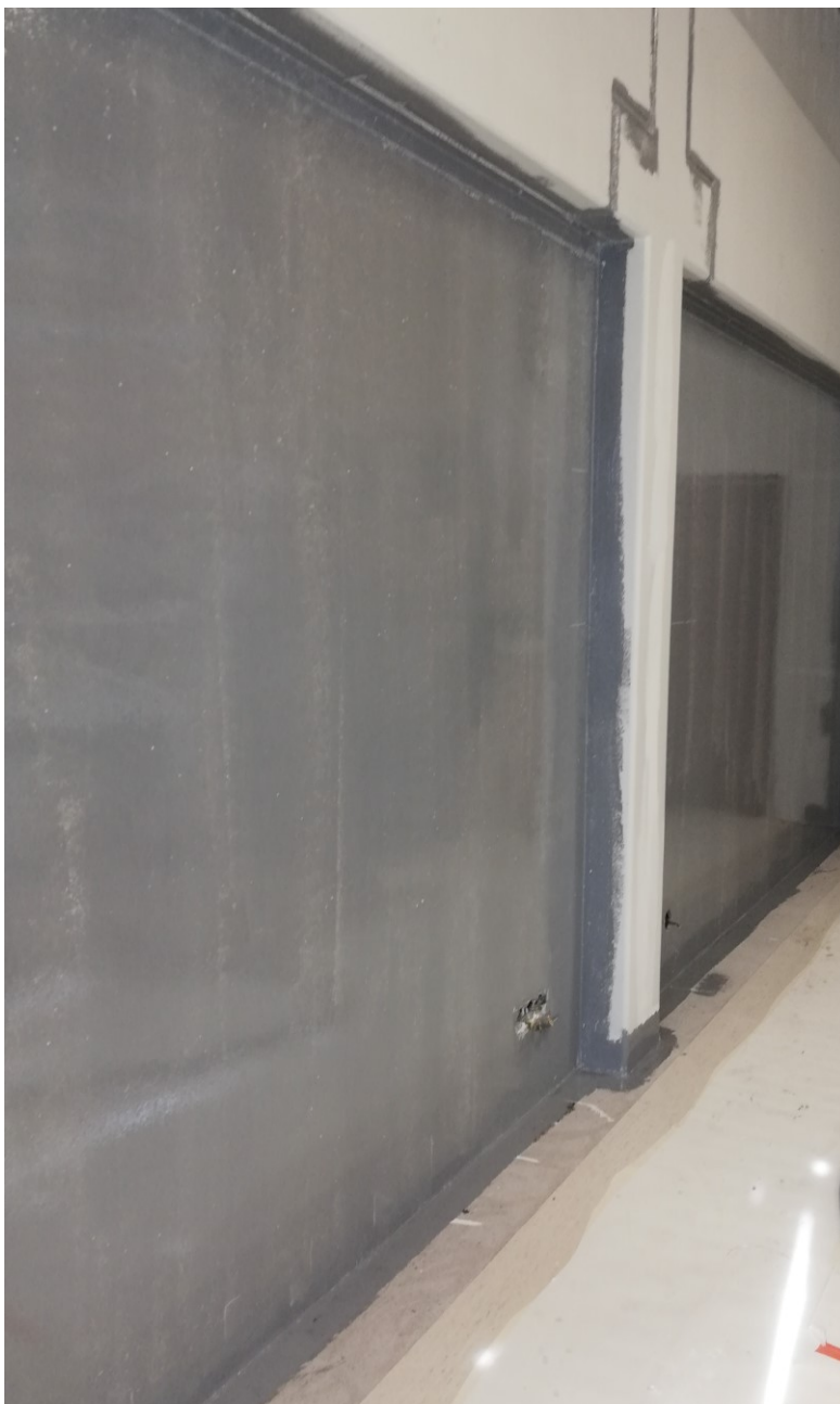
Kuva 7, TKR-asennus käynnissä. 2. kerros asennettu
