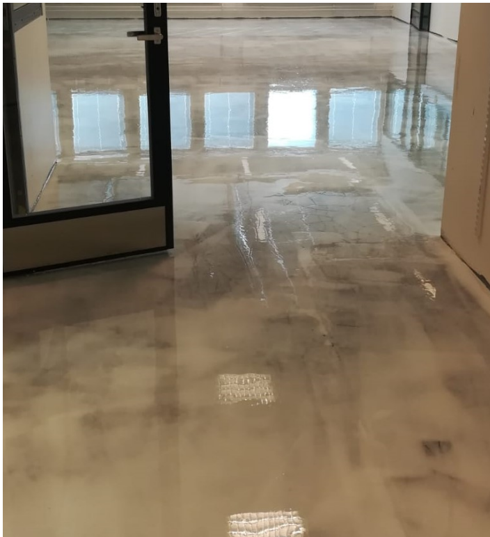
Kuva 5, Lattian tiivistys Nantenin Epoxy Barrierilla
