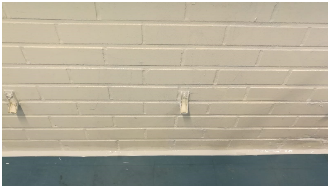
Kuva 3, patterin kannakkeet sekä lattian ja seinän raja tiivistetty ilmansulkumassalla
