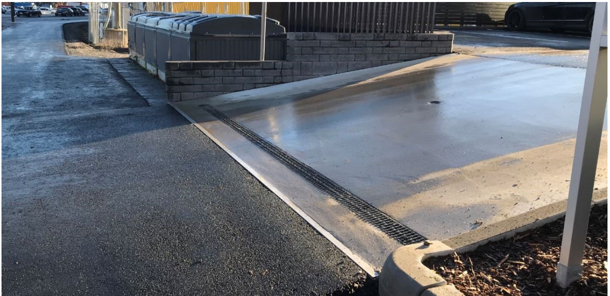
Kuva 8. Pelastustielle kääntymistä haittaava muuri (Hyvinkää, 2020).
