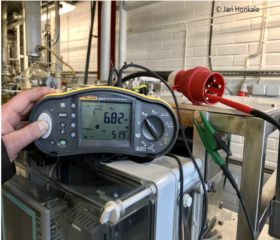
KUVA 5. Eristysresistanssin mittaus jännitteisen osan ja kosketeltavan osan väliltä
