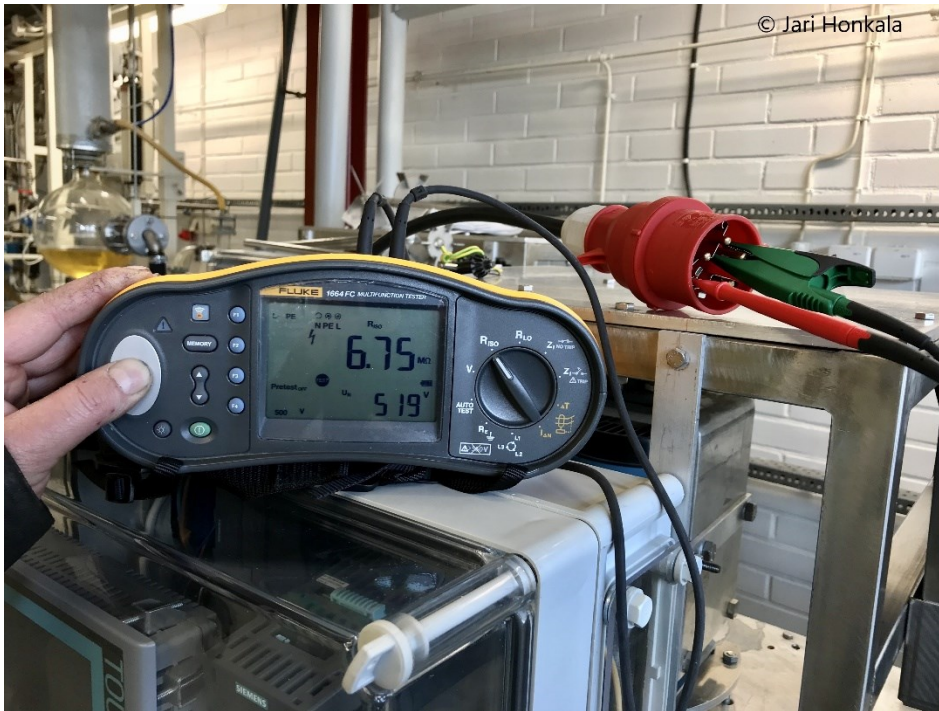
KUVA 6. Eristysresistanssin mittaus suojajohtimesta
