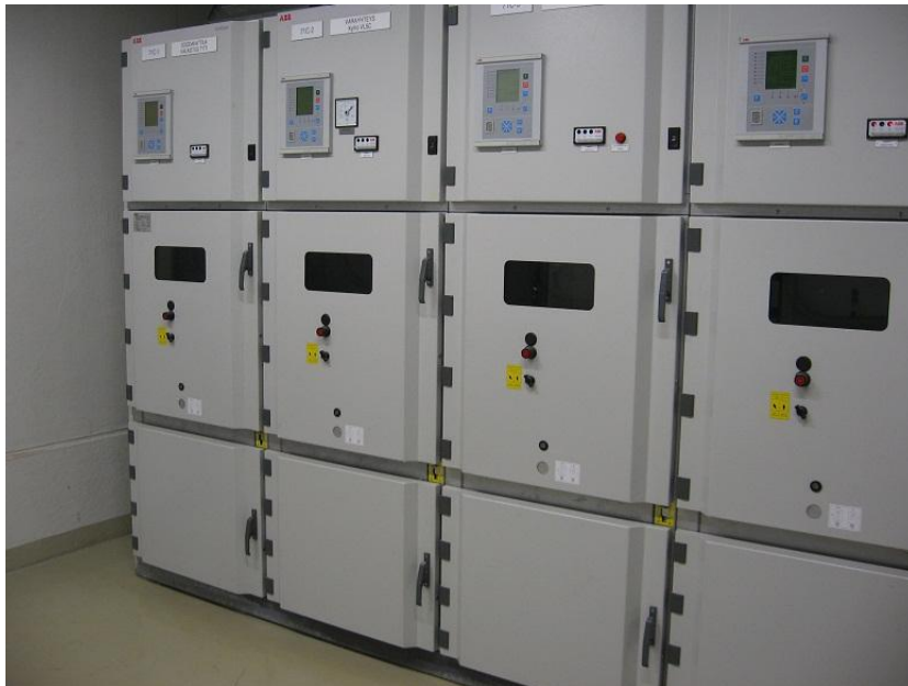
KUVA 4. Keskus 71C:n johtolähtöjen suojareleet ja katkaisijat
