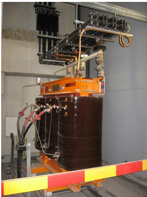
KUVA 3. Soodakattilan kuivamuuntaja 71T1
