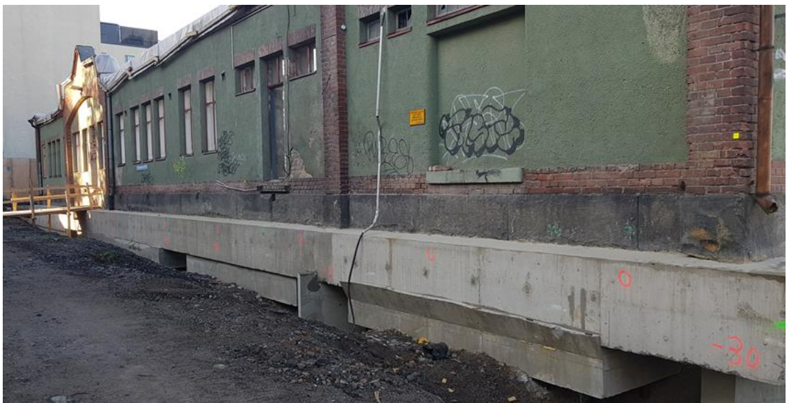
Kuva 41. Tavara-aseman uusi perustus; sokkelipalkki ja paalulaatta juotosvalun jälkeen.
