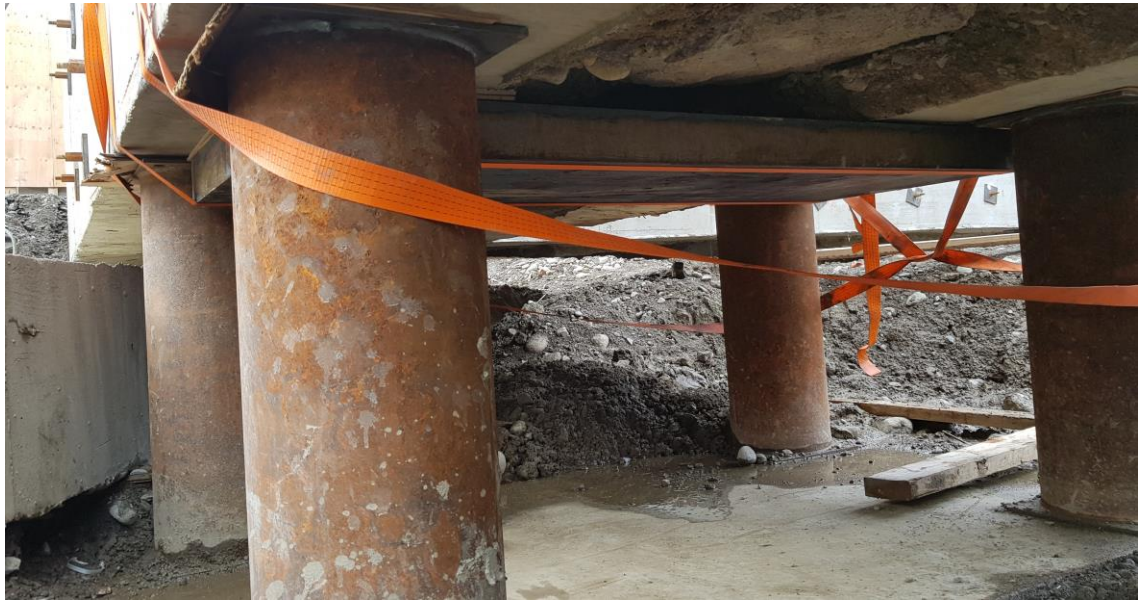
Kuva 36. Kuormantasauslevy asennettuna sokkelipalkin alapintaan.
