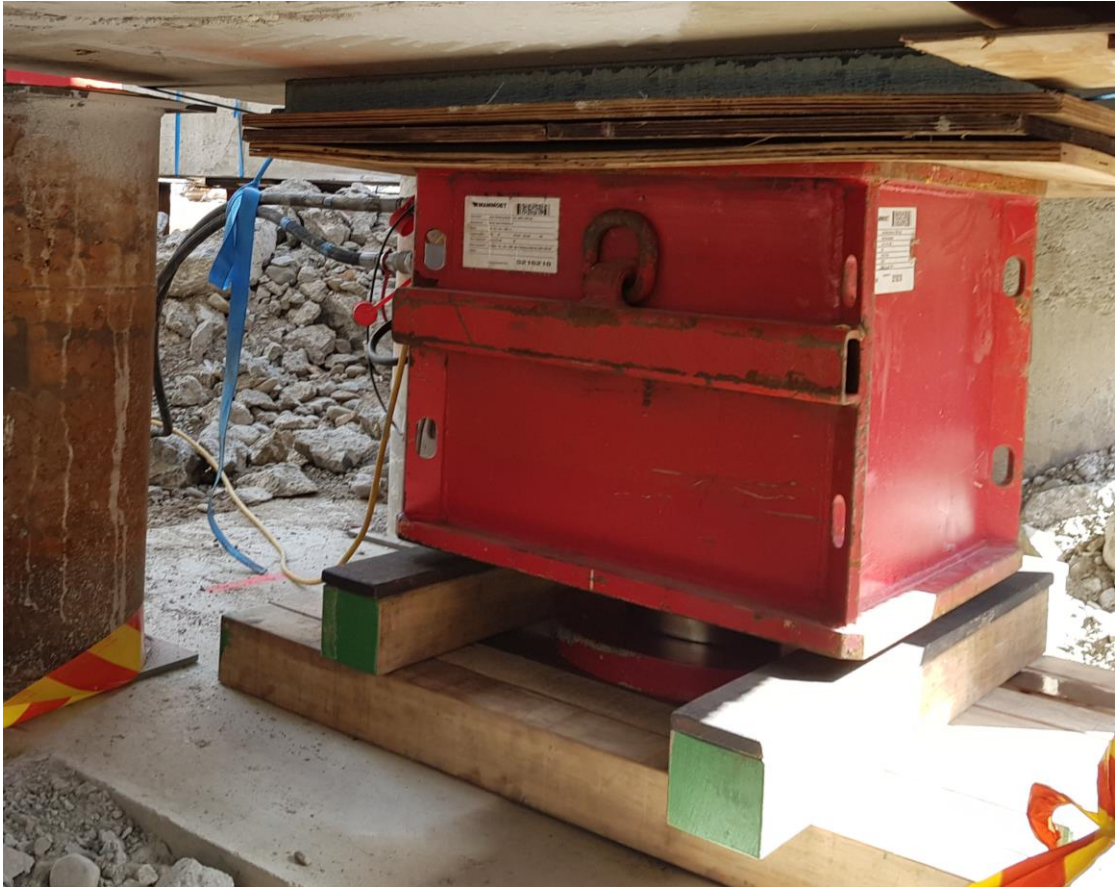
Kuva 37. Nostotunki on aloittanut rakennuksen noston, väliaikainen tuki on saatu purettua.
