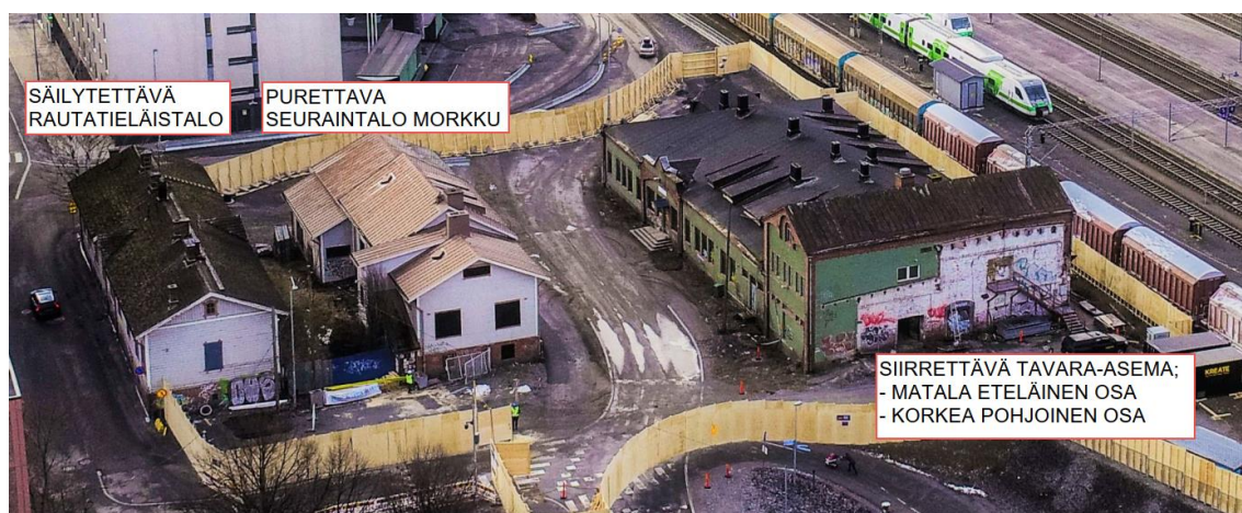
Kuva 4. Ilmakuva lähtötilanteesta, jossa näkyvät purettavat, säilytettävät ja siirrettävät rakennukset.
