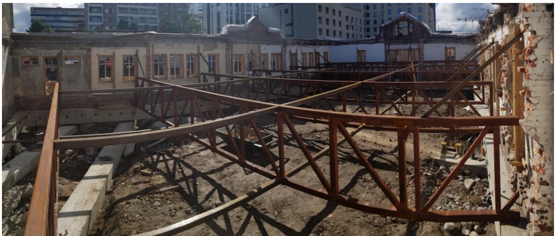
Kuva 35. Siirron aikaiset teräsristikot rakenteen jäykisteenä.
