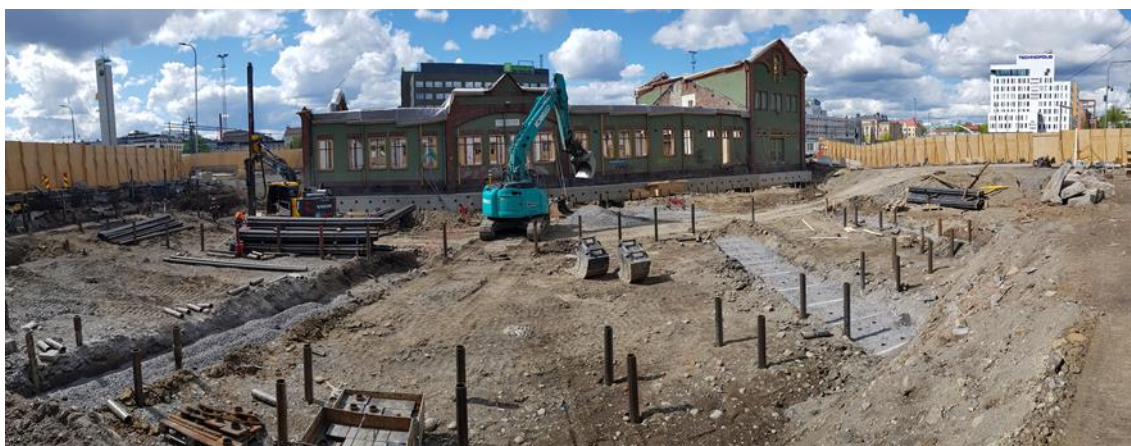
Kuva 28. Uusien perustusten maarakennustyö käynnissä.
