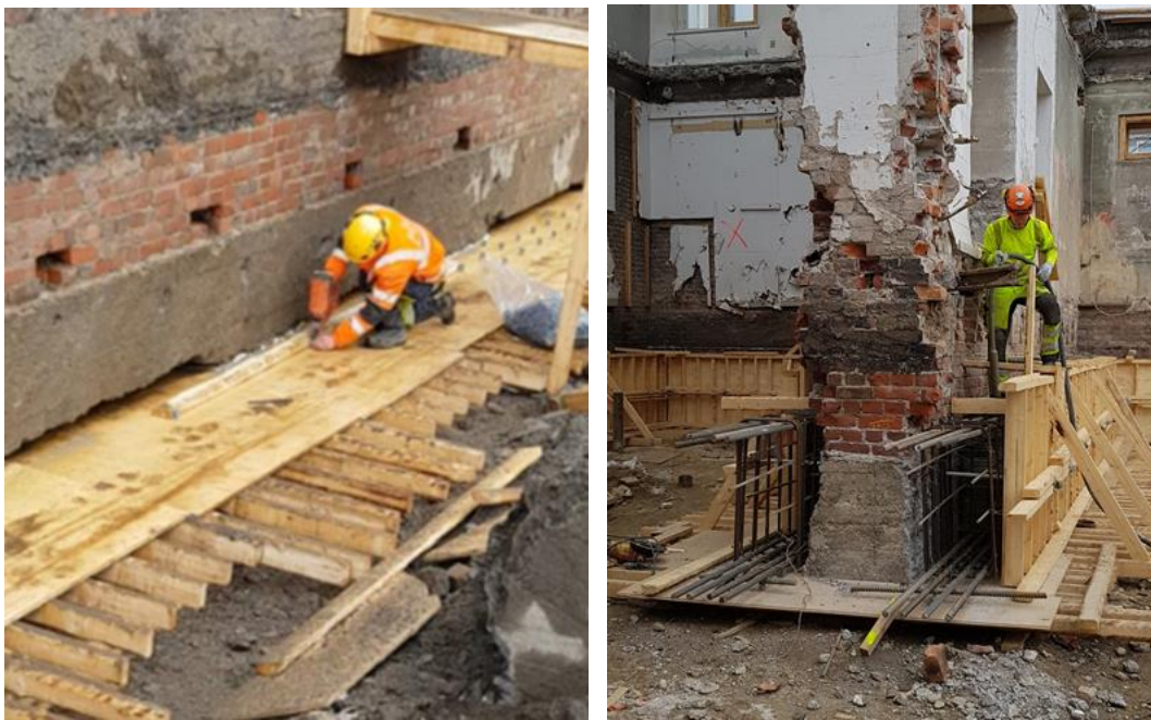
Kuva 24. ja 25. Vasemmalla teräsbetonipalkiston vahvistaminen sokkelipalkilla, oikealla väliseinän sokkelipalkin osan valutyö käynnissä.
