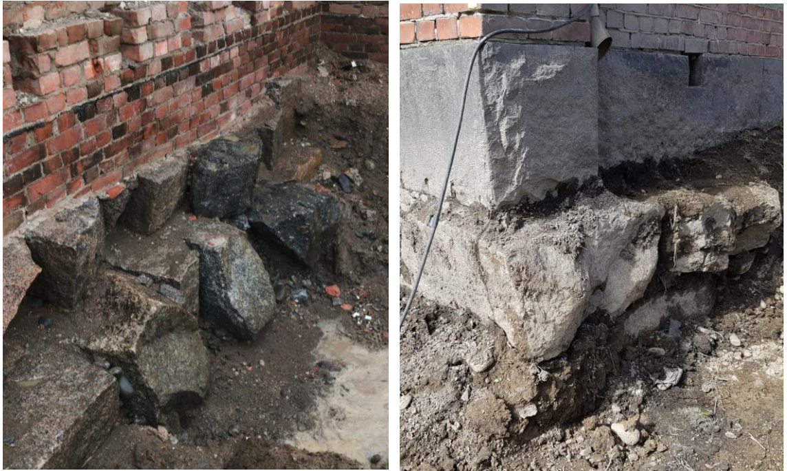
Kuva 16. ja 17. Vasemmalla sisäpuoliset, ja oikealla ulkopuolelta lohkottavat perustuskivet.
