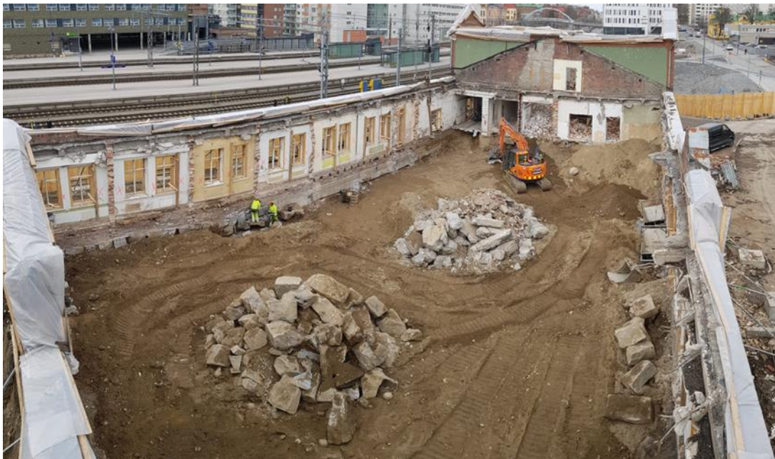
Kuva 13. Sisäpuoliset purkutyöt käynnissä.
