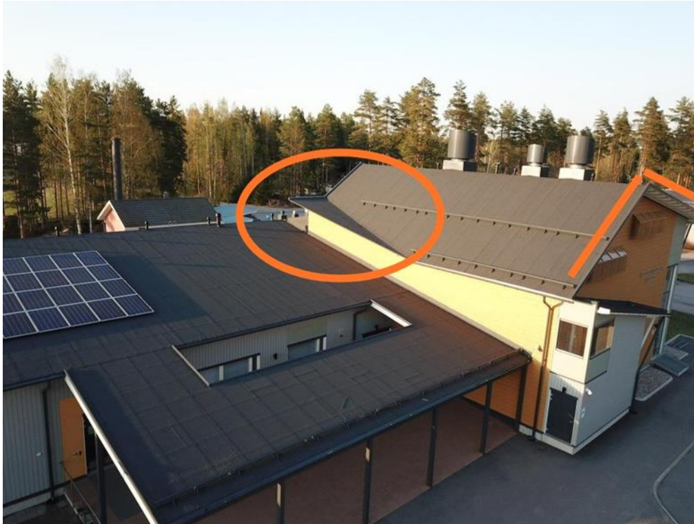
Kuva 17. Lokinsiipi ja kattokulmat.
