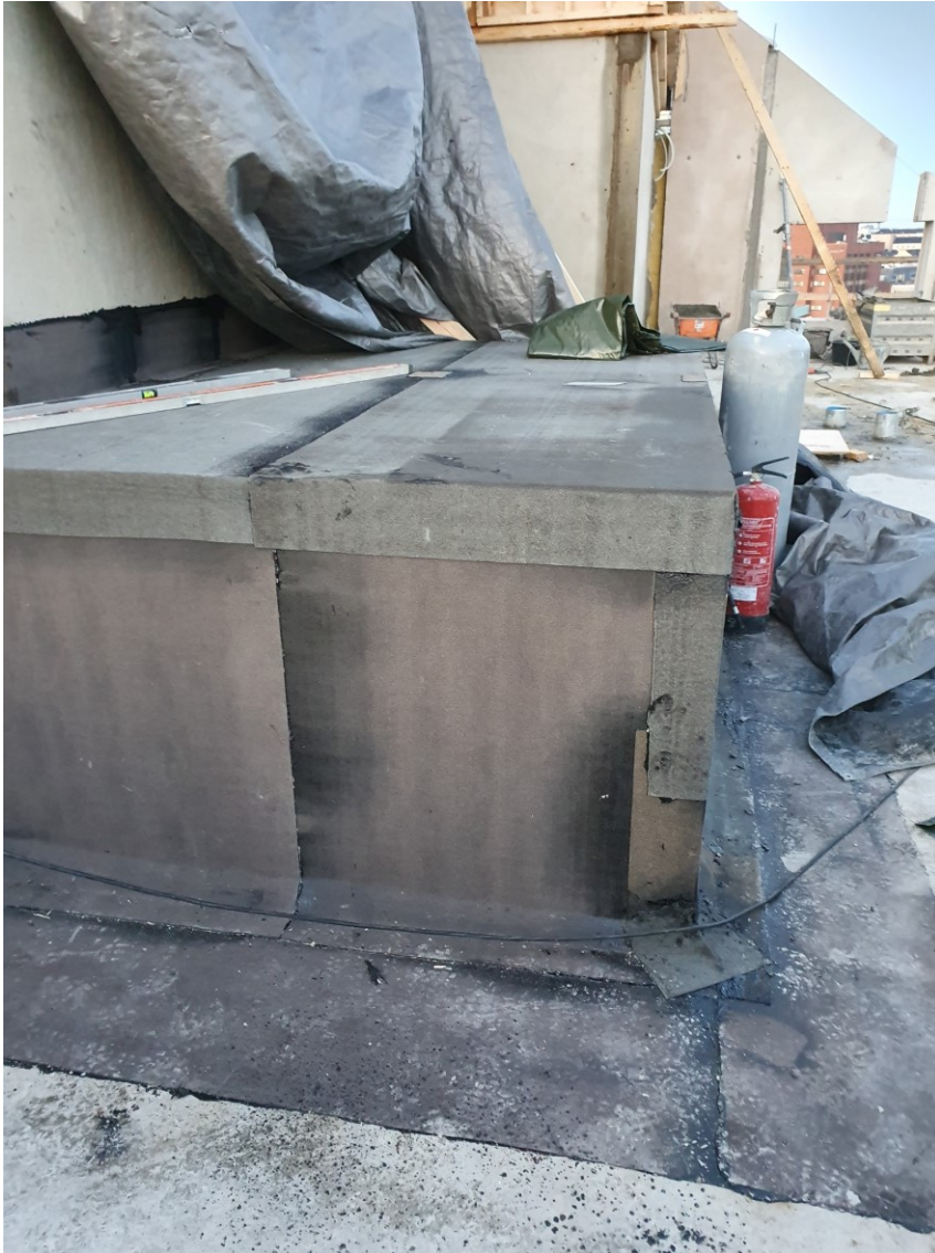
Kuva 9. Hissikuilun yläkuppi eristetty bitumikermillä
