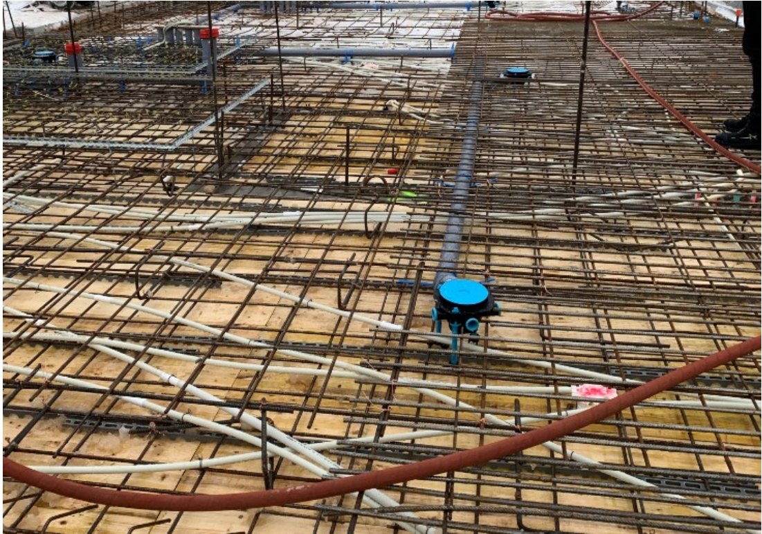
Kuva 8. Lisäkaivot paikallavaluholvissa ennen valua
