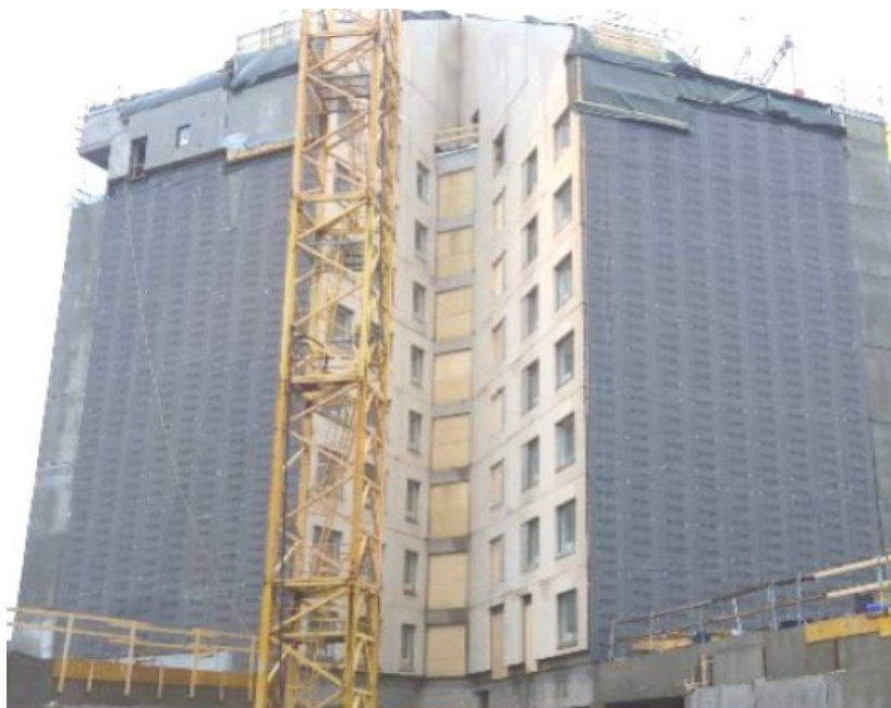
Kuva 17. Tuulensuojavillat asennettu liikuntasaumaseiniin, yläpää suojattu pressuilla.
