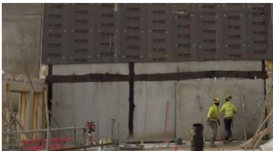
Kuva 18. Liikuntasaumaseinän vaaka- ja pystysaumojen bitumikermi
