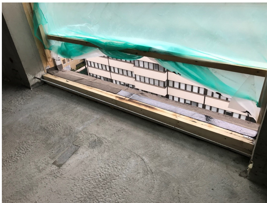
Kuva 12. Apukarmi suojattu bitumikermillä (Tölkö Antti)
