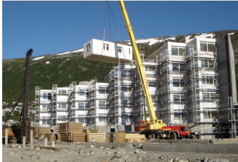
Kuva 4. Tilaelementin nosto paikoilleen [19].
