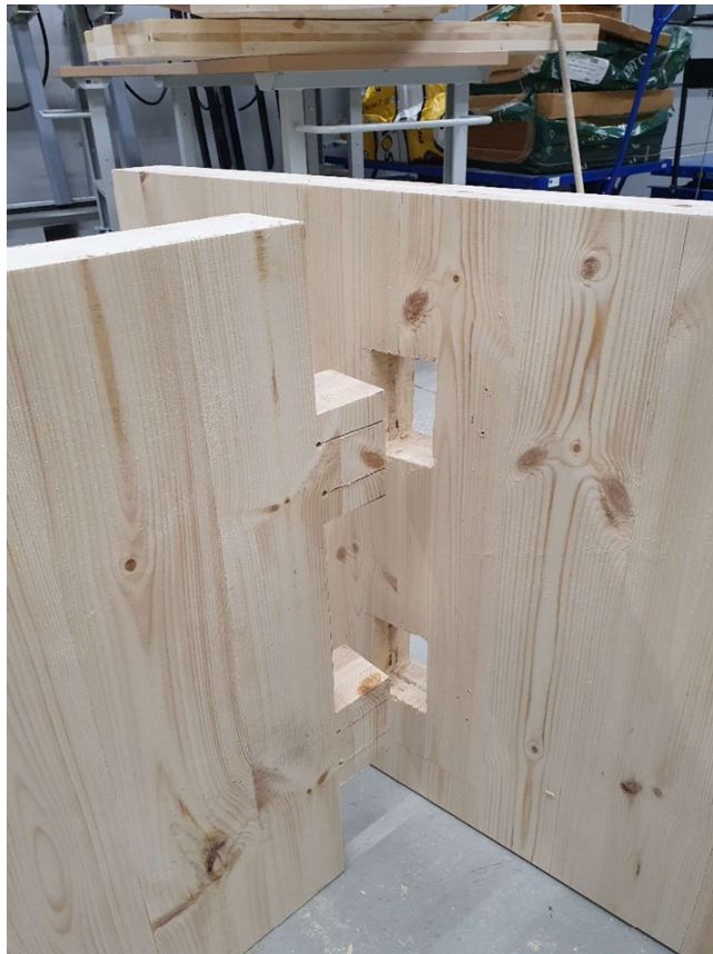
Kuva 19. Urospala ja naaraspala väliseinäliitoksessa
