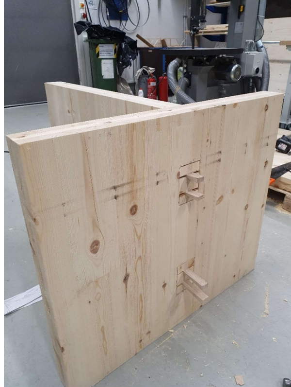
Kuva 21. Seinäelementit on liitetty toisiinsa ja liitos lujitettu kiilaamalla.
