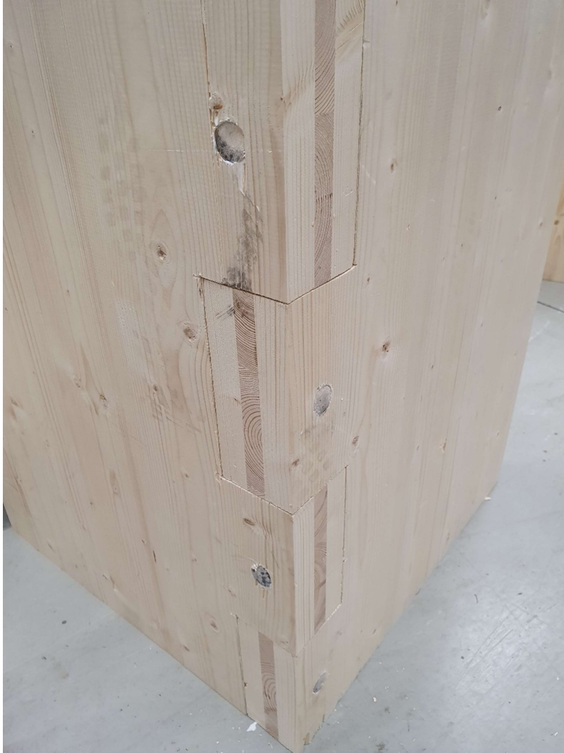
Kuva 26. Nurkkaliitos valmiina. Tappeihin on laitettu liimaa ja lyöty sisään.
