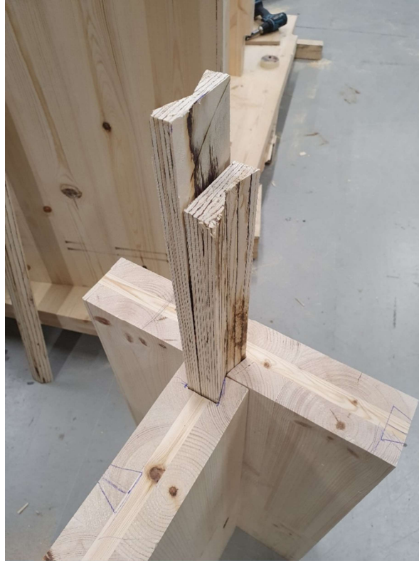
Kuva 23. Kertopuusta valmistetut kiilavat liitoskappaleet lyödään lekalla sisään
