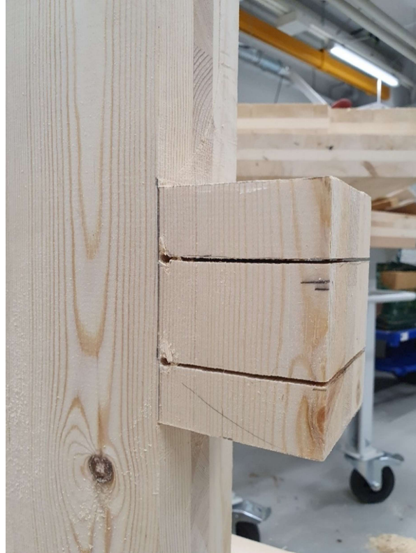
Kuva 20. Urospala halkaistu kahdesta kohdasta kiilausta varten
