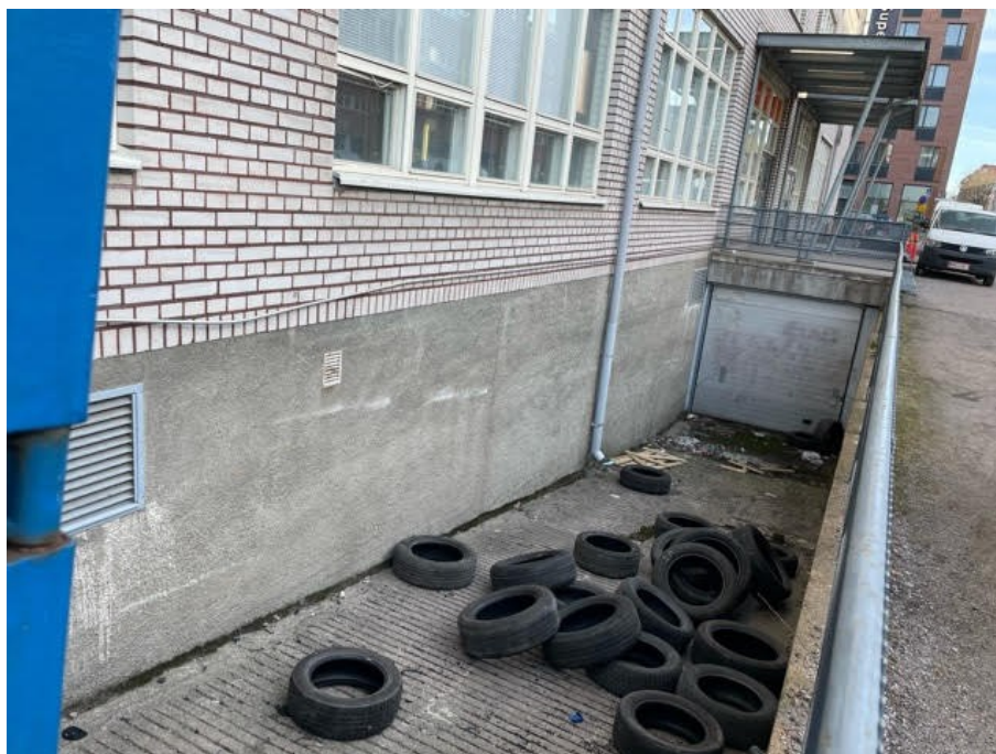
Kuva 21. Käytöstä poistettu ajoluiska K3-varastolle ulkona.
