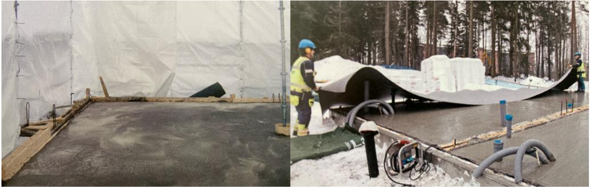
Kuva 7. Laattavalun suojausmenetelmiä. (Pistesarjat n.d.).
