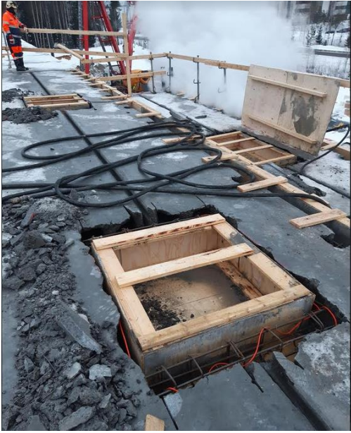
Kuva 9. Ontelolaattojen saumavalu. (Holma 2021)
