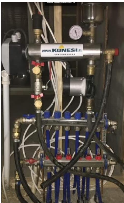
Kuva 5. Läpivirtausvastus lämmitin asennettuna.
