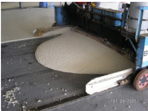
Figur 2. Motordriven läggarbalk ( Asfaltboken , u.å.)
