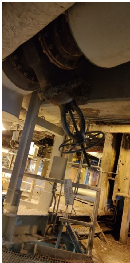
KUVA 12. Eristämätön matalapainehöyryn sulkuventtiili (Lohikainen 2021).
