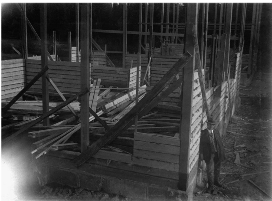
Kuva 47. Kuvassa Puu-Käpylää rakennetaan. Rakenne syntyy pystysuuntaisista hirsistä ja niiden väliin täytettävistä lyhyemmistä hirsistä. Valokuva: Otto Wuoria (1920), Helsingin kaupunginmuseo.
