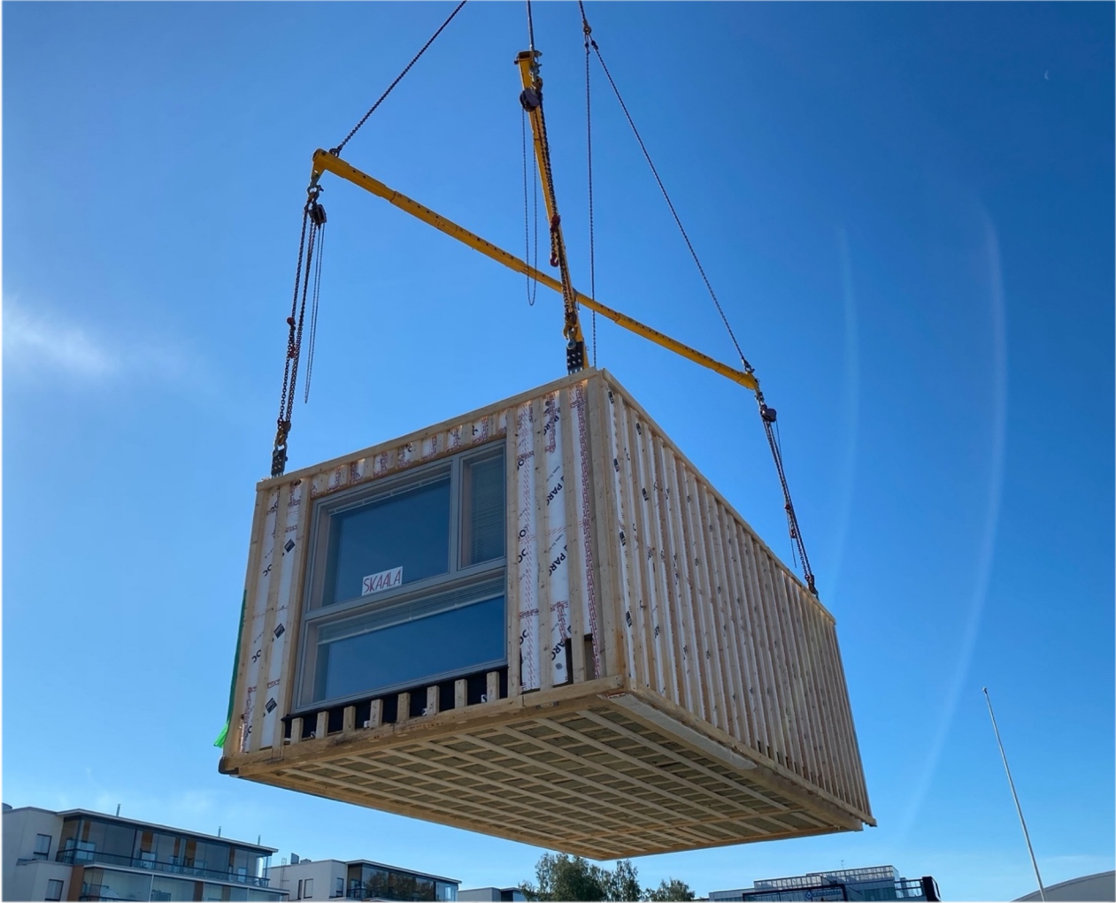
Kuvio 3 Tuuliniityn ensimmäinen massiivipuutilaelementti menossa paikalleen
