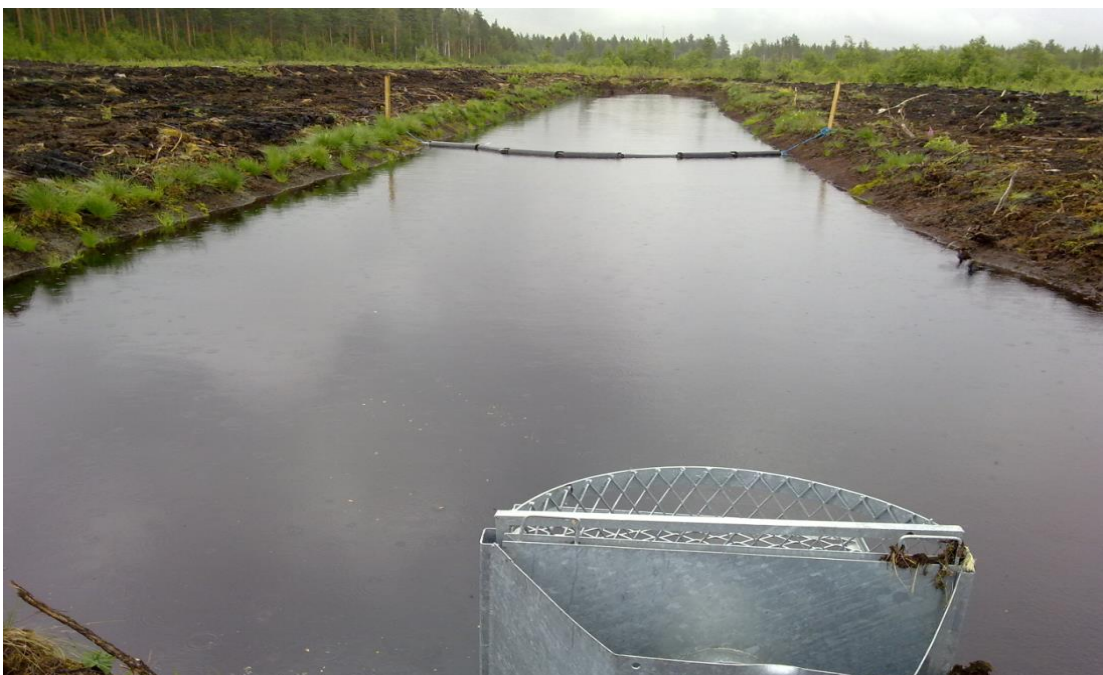
Turvetuotannon laskeutusallas, jota voisi hyödyntää myös jälkikäytön vesien puhdistuksessa.
