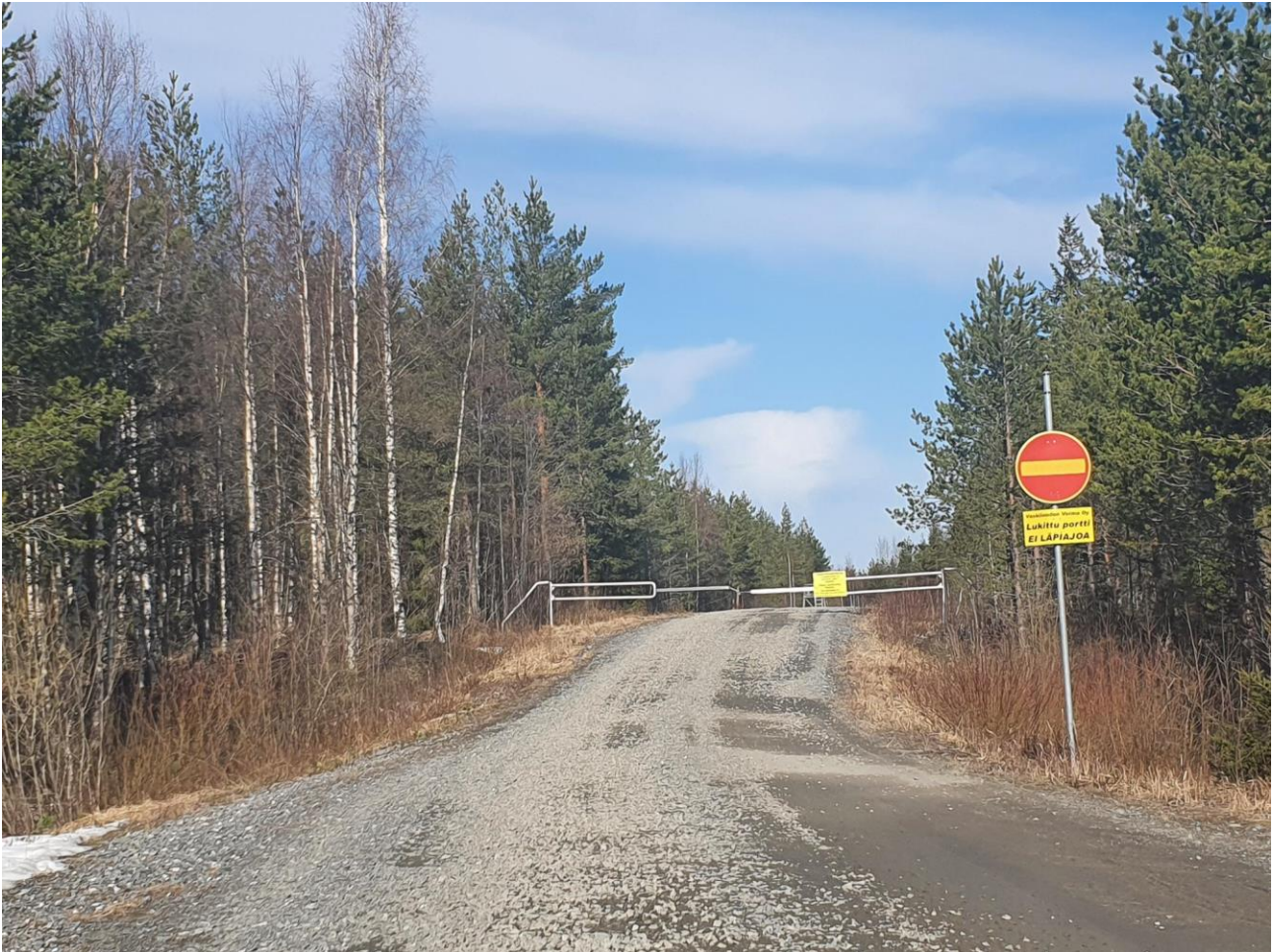
Turvetuotannon aikana infra rakennetaan hyväksi.
