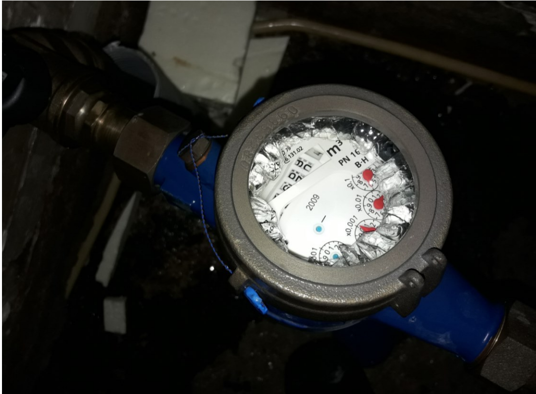
Kuva 22. Vesimittarin lasi rikkoontunut.
