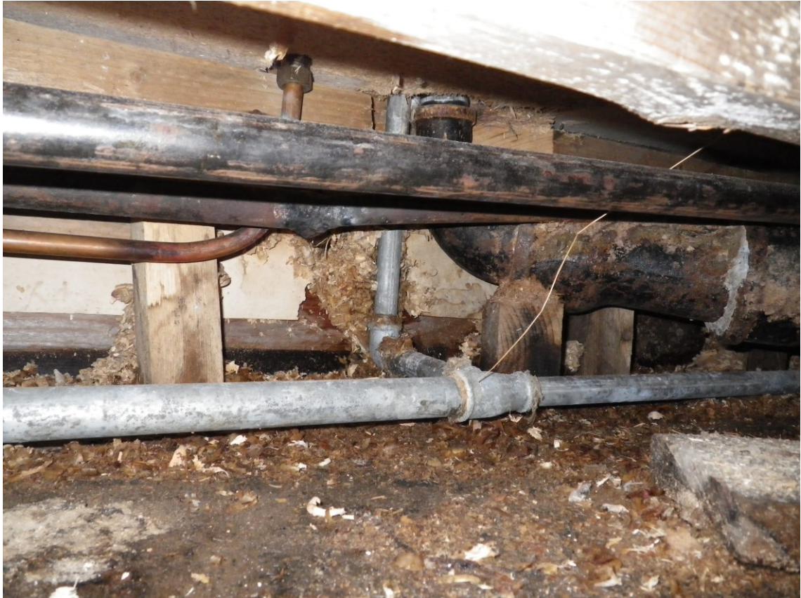
Kuva 9. 60-luvun omakotitalon alapohjan eristetilä, jossa valurautaviemäri, galvanoitu kylmävesijohto, kuparinen lämminvesijohto ja hitsaamalla jatkettut ns. ”mustat” lämpöjohdot.
