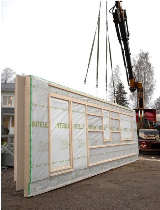
KUVA 2. Ulkoseinäelementin asennus käynnissä (13)
