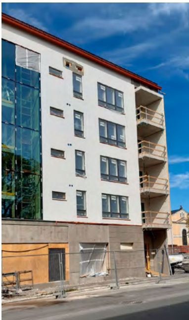
Kuva 1. Karhunpesän työmaa kesälä 2020 (Kuva: Mari Kujala 2020).
