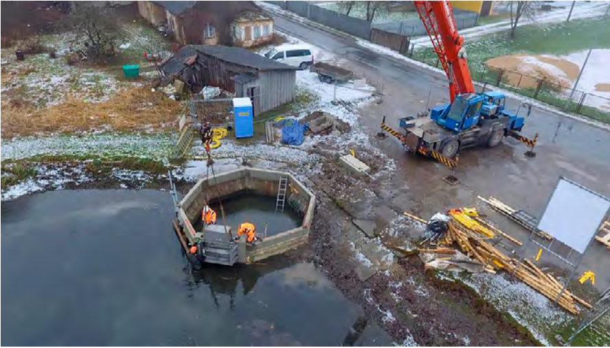
Kuva 4. Patoseinän ja automaattisen patoluukun rakennustöitä Rakveressa joulukuussa 2020 (Kuva: Kristian Pärtma/Nordpont OÜ 2020).
