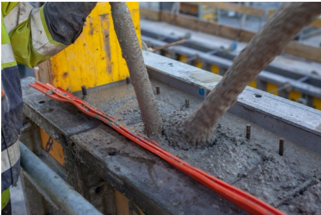
Kuva 7 Betonia pumpataan raudoitettuun muottiin ja tiivistetään täryttämällä. (Kuva: Suomen Betoniyhdistys ry)
