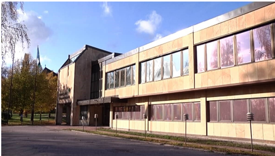
Kuva 13. Pohjan kunnantalo ennen korjausta.
