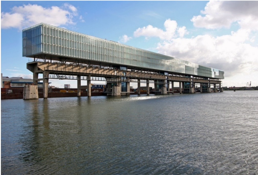
Kuva 5. Kraanspoor-rakennus kuuluu fragmentaaristen isäntärakennusten ryhmään.
