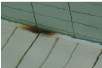
Kuva 30. Virheellisen materiaalin aiheuttama korroosioaurio.
