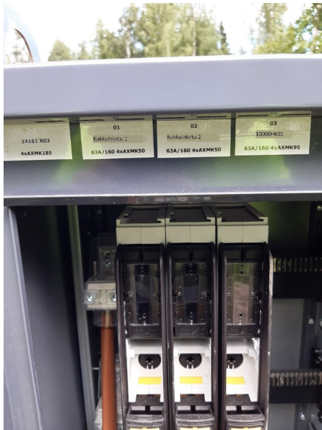
KUVA 20. Kaapelitiedot ja osoitteet ryhmittäin.
