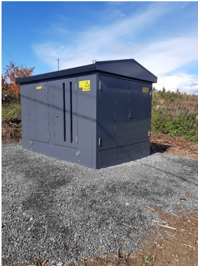
KUVA 9. Yleiskuva puistomuuntamosta ulkoa.
