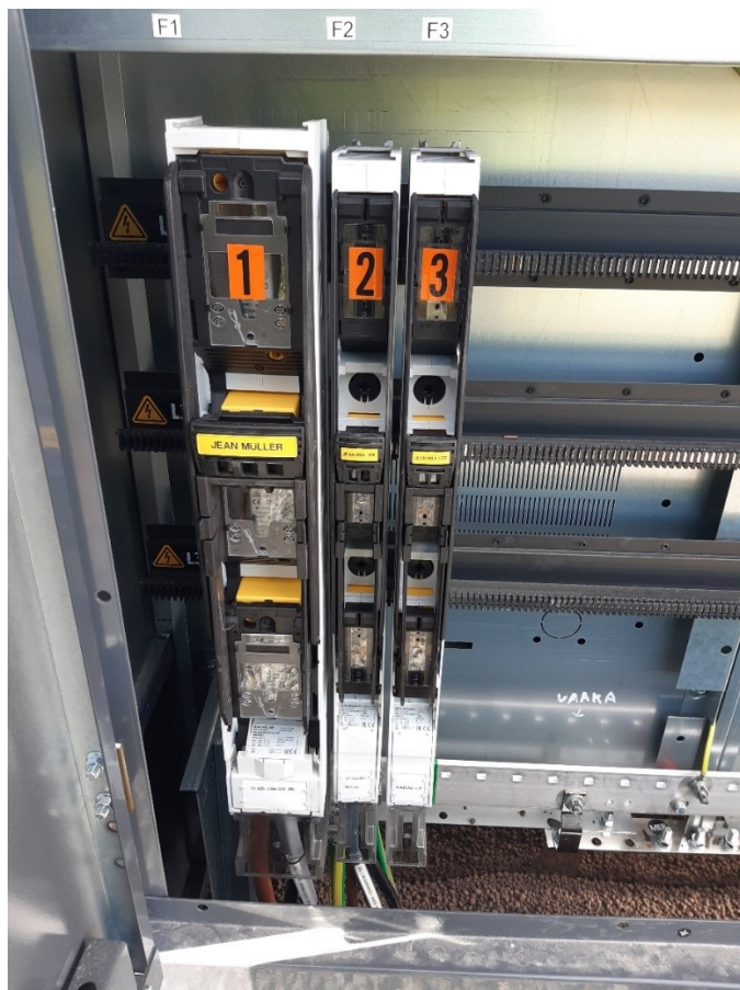
KUVA 11. Muuntamon jonovarokeytkimet.
