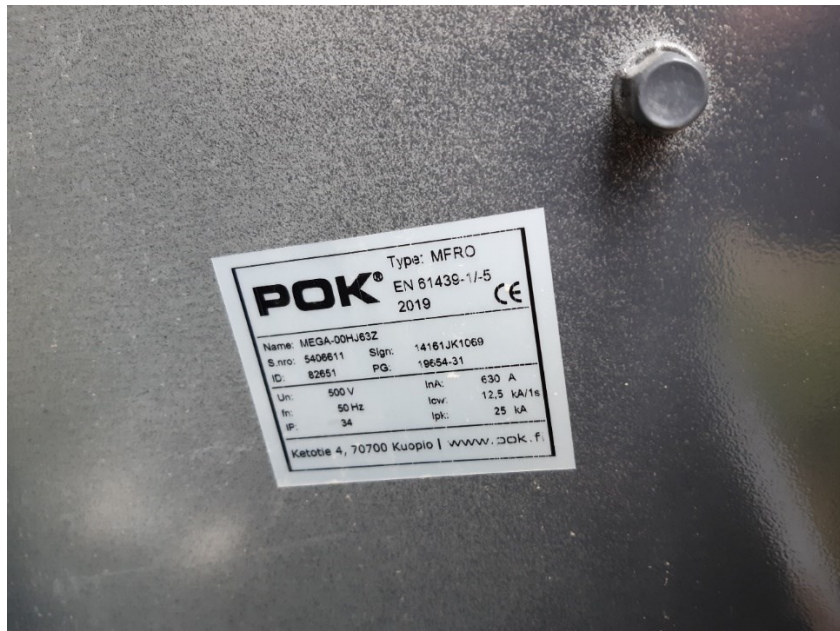
KUVA 22. Jakokaapin tyyppikilpi.
