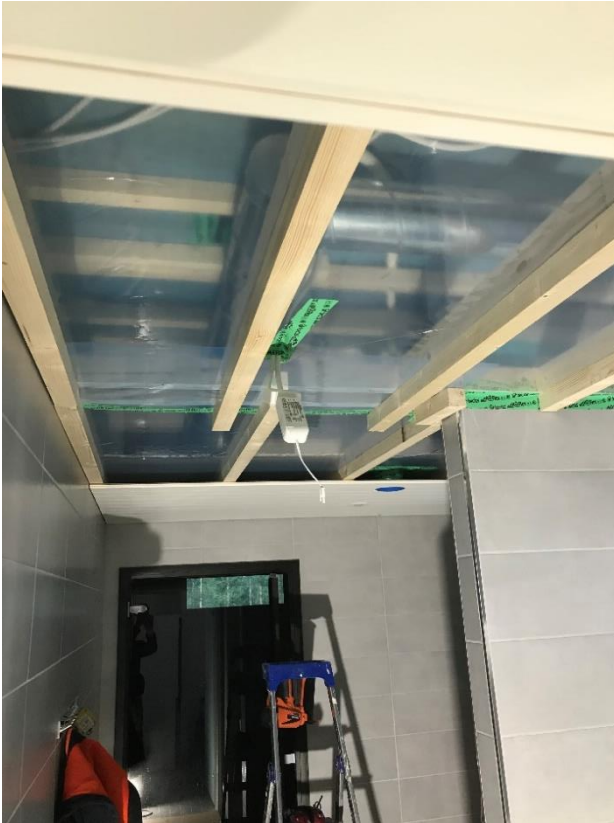
Kuva 3. Höyrynsulun asennus 30.03.2020 2. mittausjaksoon.
