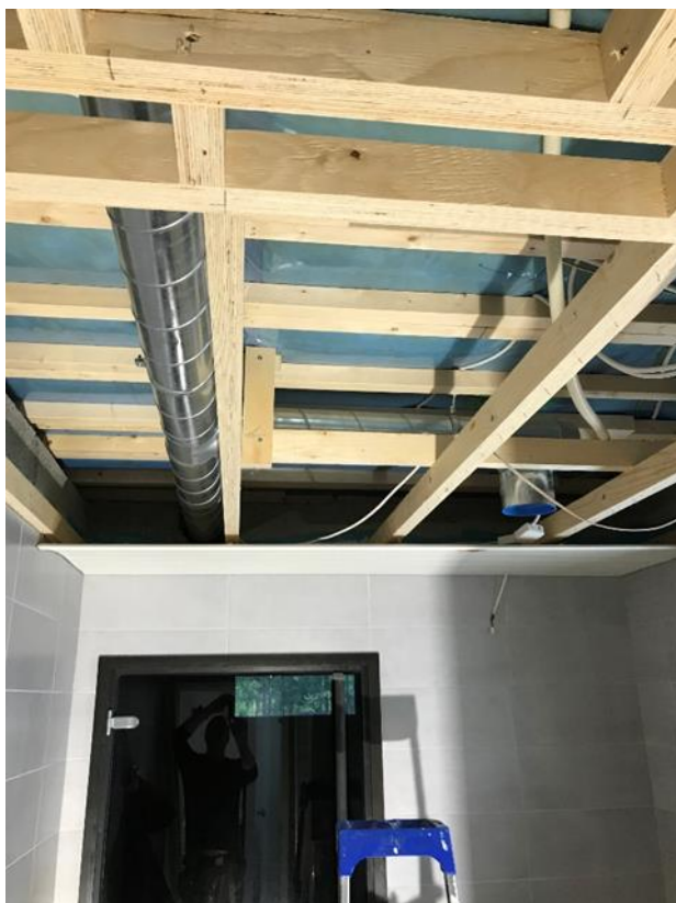
Kuva 6. Paneelikatton purku 30.03.2020 1. mittausjakson jälkeen (liite 2)
