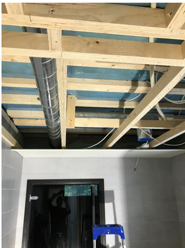
Kuva 2. Paneelikatton purku 30.03.2020 1. mittausjakson jälkeen.
