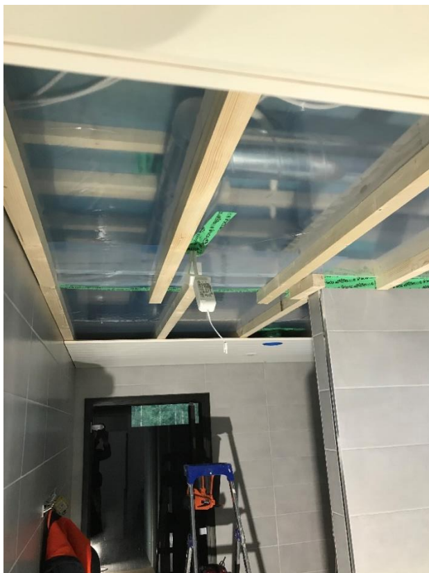
Kuva 7. Höyrynsulun ja uuden paneloinnin asennus 30.03.2020 2. mittausjaksoon (liite 2)
