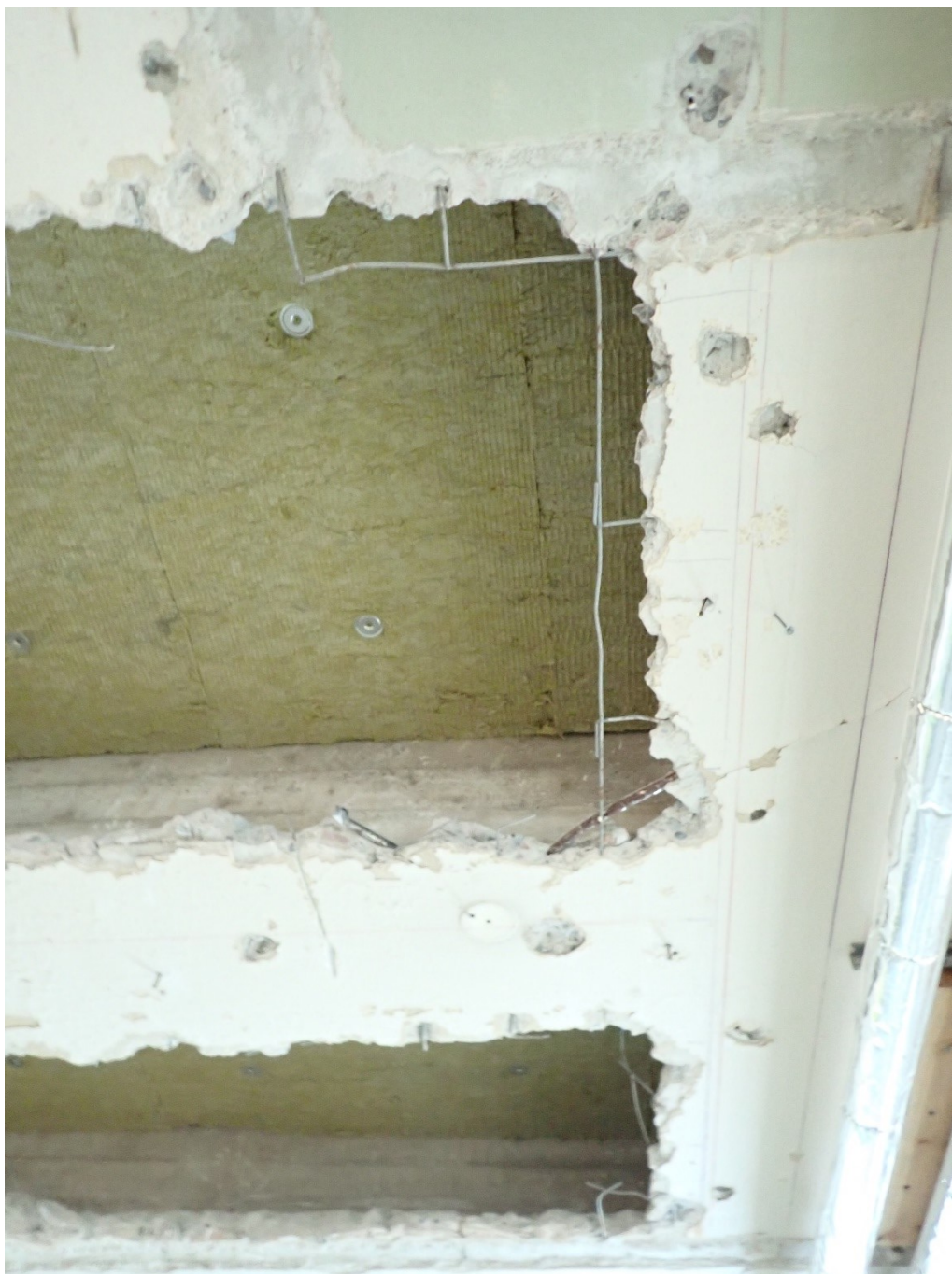
KUVA 14. Kaksoislaattapalkisto, jossa alapuolinen laatta on purettu ja mineraalivillaeristys lisätty.
