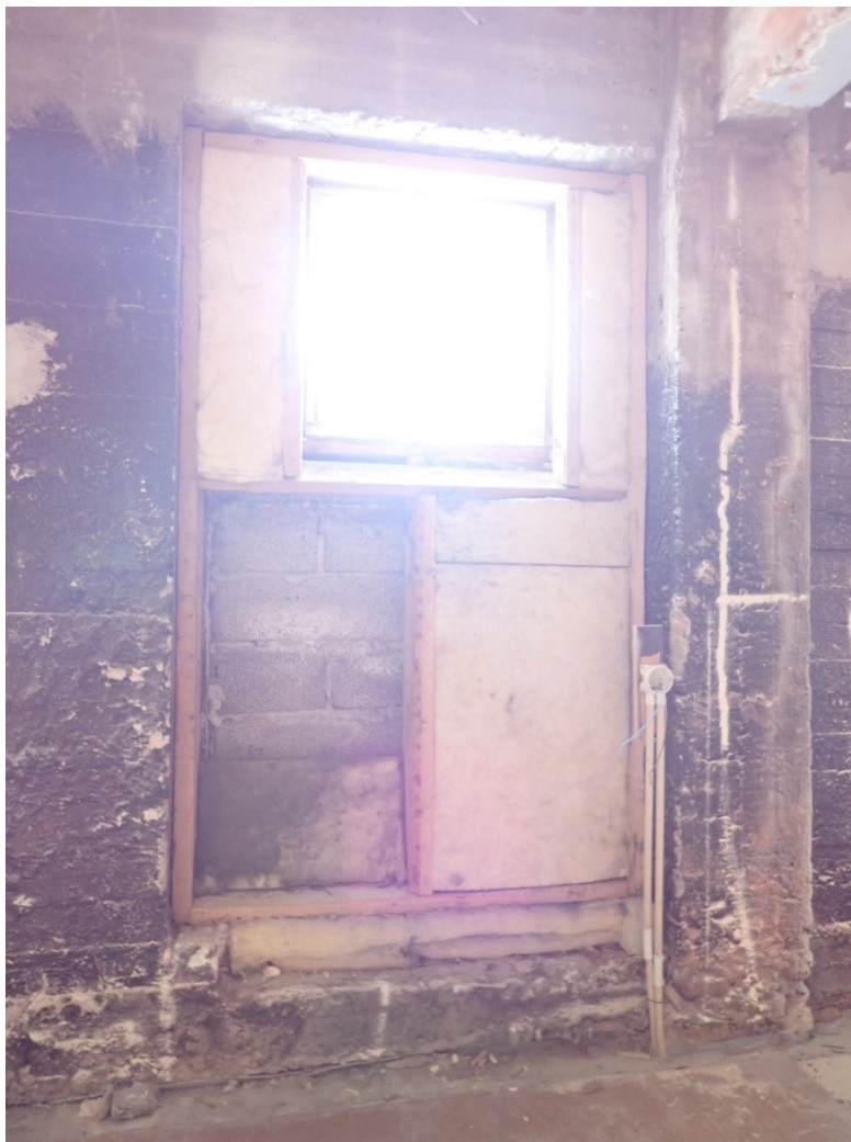
KUVA 13. Kellaritiloissa oleva umpeen laitettu oviaukko.
