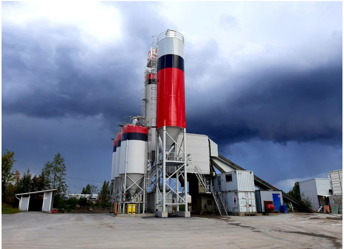
Kuva 6. Lujabetoni Oy:n kiinteä valmisbetoniasema
