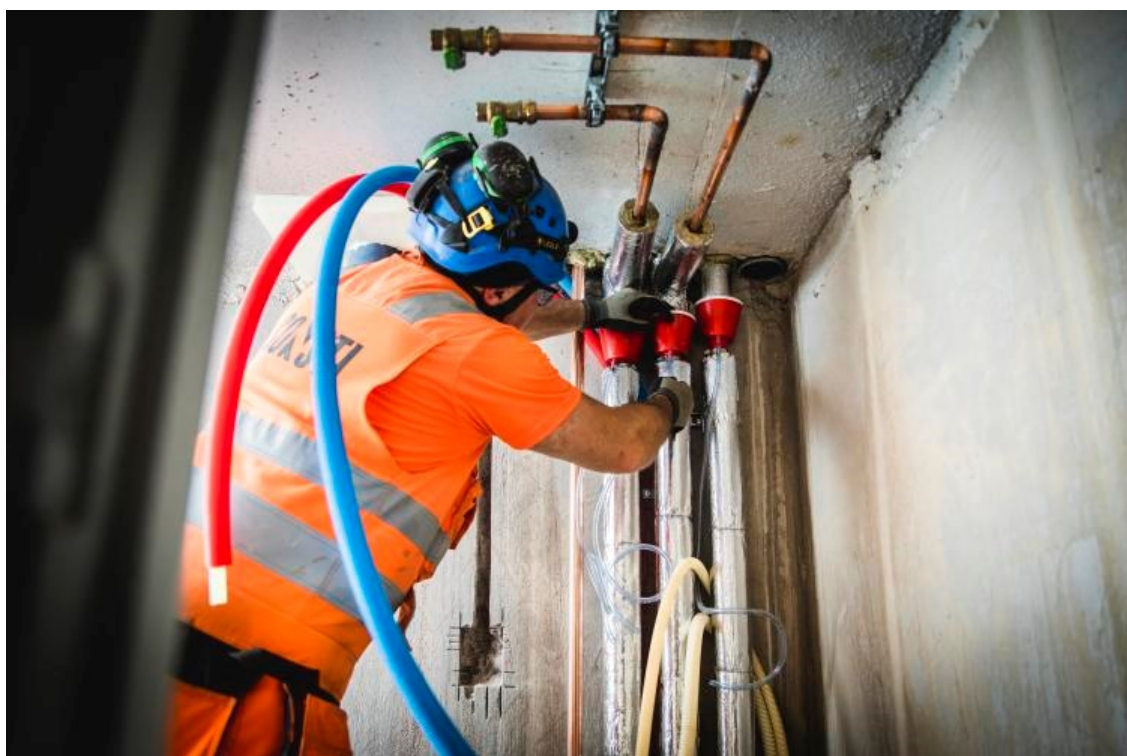
Kuva 13. Uuden tekniikkanousun rakentamista, perinteinen linjasaneeraus. [6]
