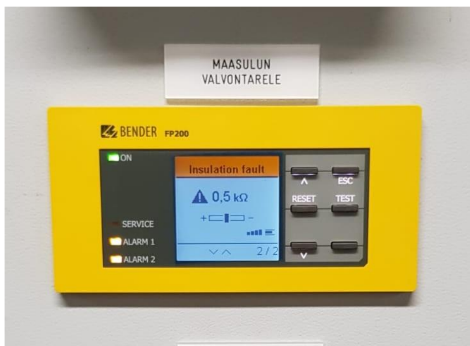
Figur 13. Alarm vid jordslutning.
