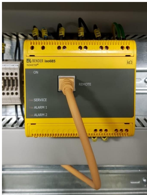
Figur 12. Reläet ISO685-S i huvudcentralen 2BFM.
