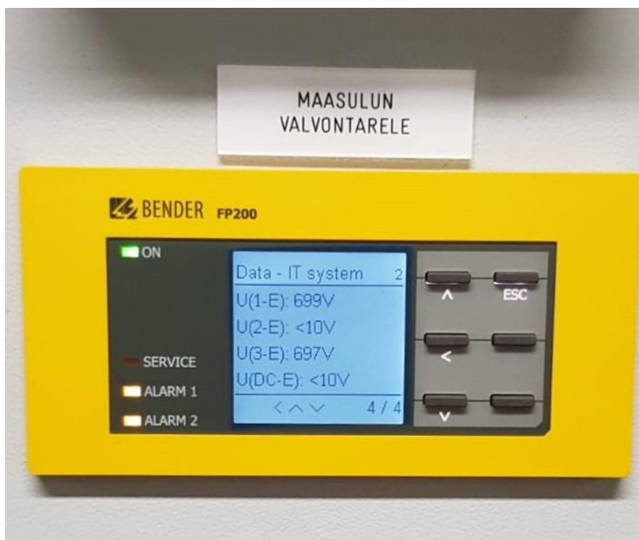
Figur 14. Fasspänningarna vid jordslutning.
