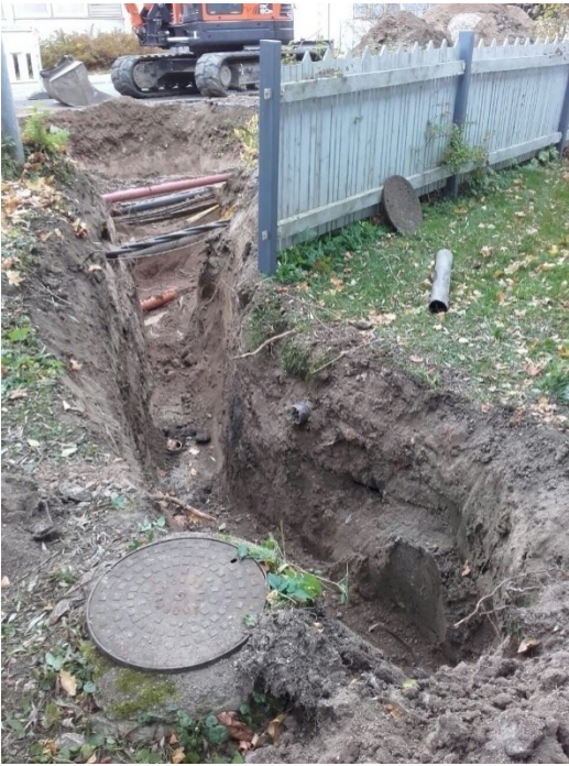
Kuva 7, Havainto kalliopinnasta 2016 viemäritöiden yhteydessä (kuva saatu tilaajalta)
