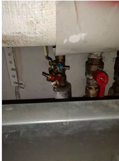
Kuva 8. Linjasäätöventtiili Oras 4100 lämpimän käyttöveden kiertojohdossa [Kuva: Aatu Uotila].
