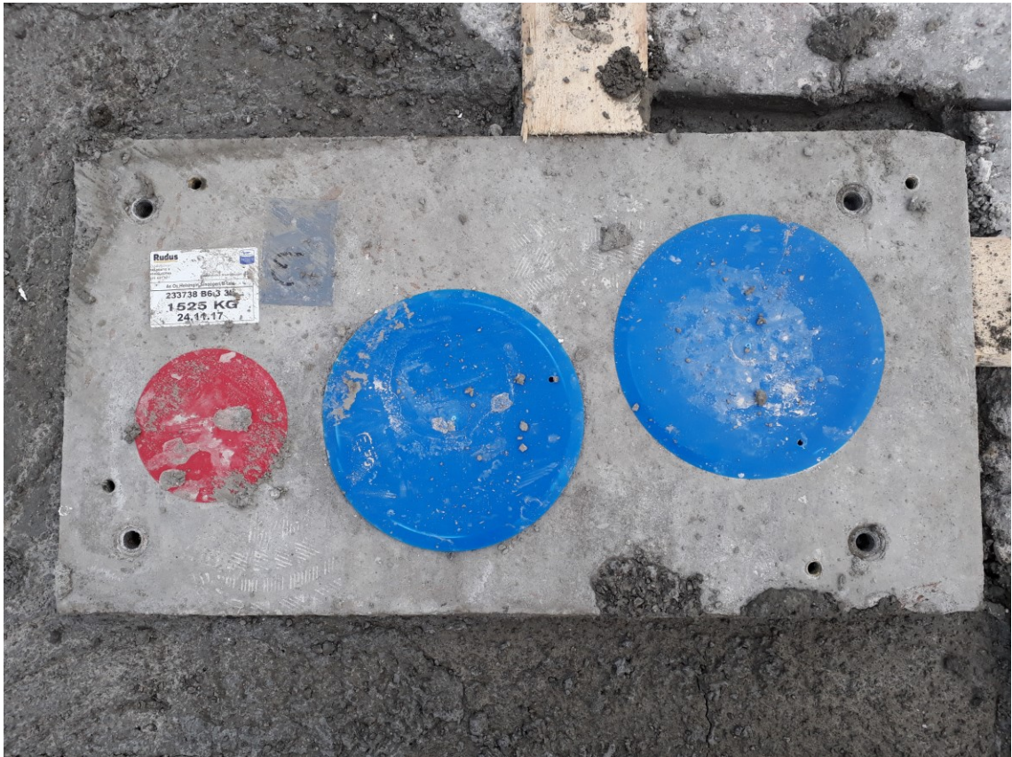
Kuva 2. Elpo-hormi kuvattuna yläpäästä paikalleen asennettuna ja kiinni valettuna
