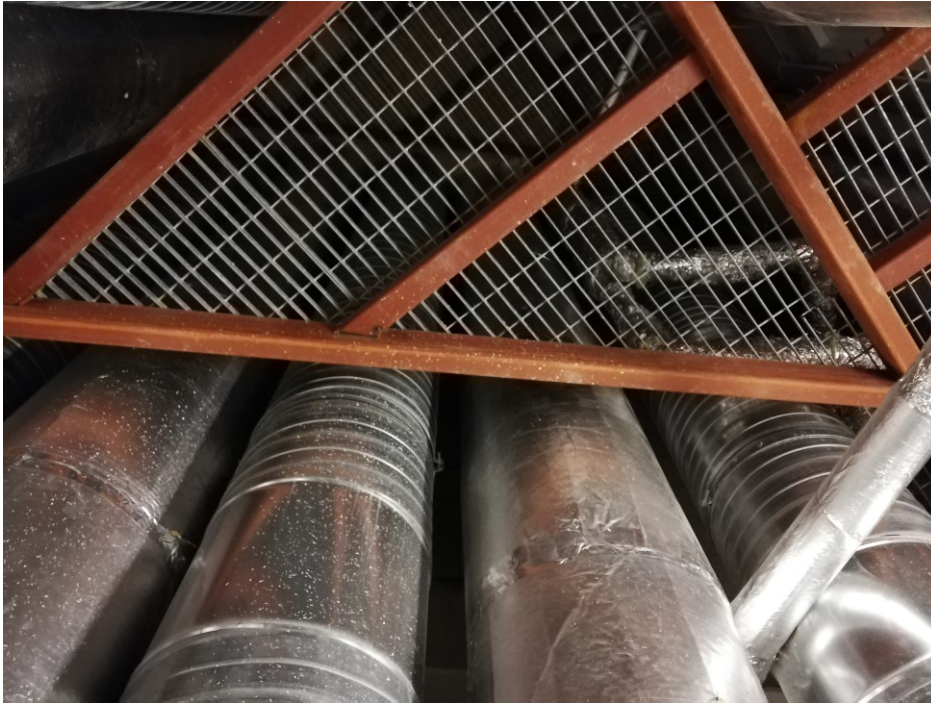
Kuva 35. Huoltotaso kuvattuna alapuolelta
