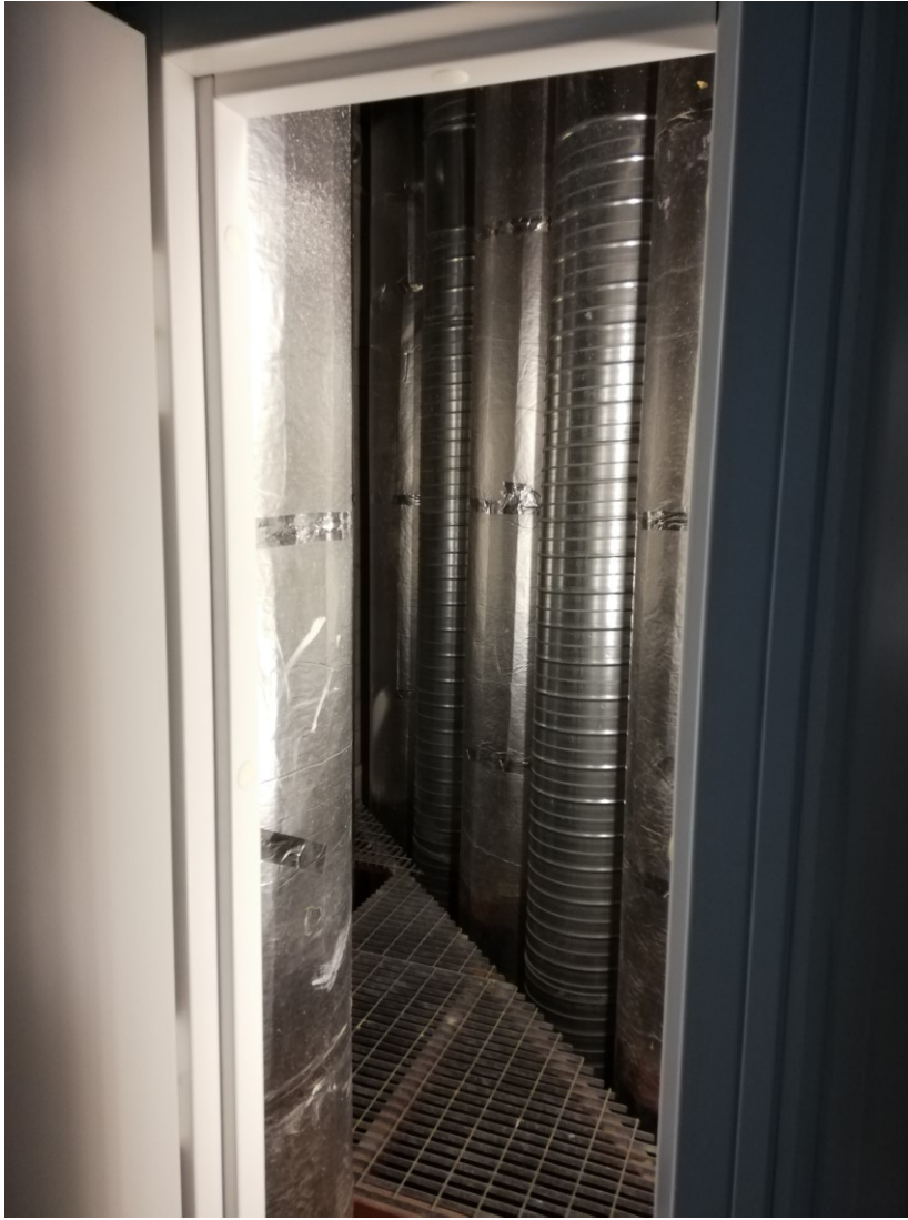
Kuva 34. Näkymä tekniikkakuilun ovelta
