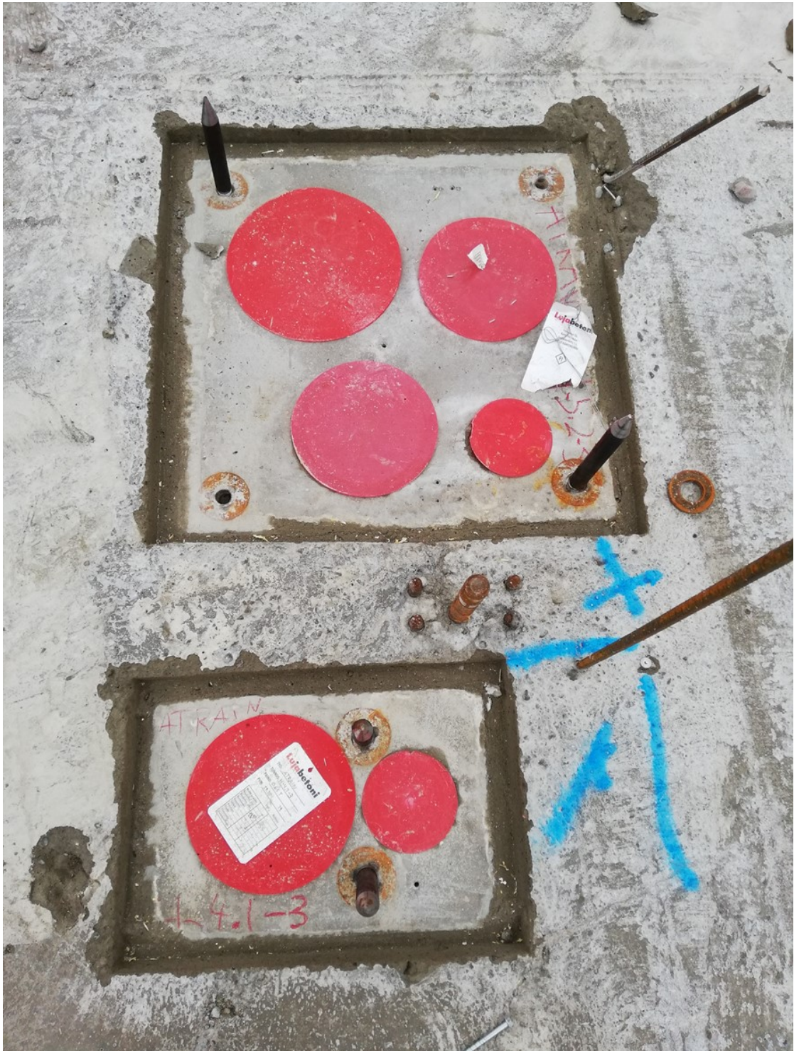
Kuva 3. Luja-hormielementit kuvattuna yläpästä paikalleen asennettuna
