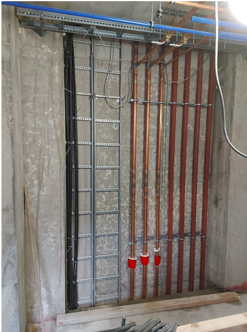
Kuva 37. Komeromallinen tekniikkakuilu, johon asennukset ovat käynnissä.
