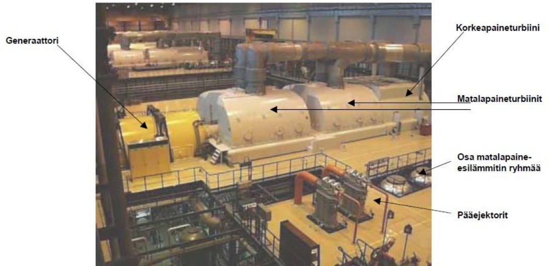
Kuva 11. Loviisan voimalaitoksen turbiinihalli (Fortum Power & Heat Oy 2002)
