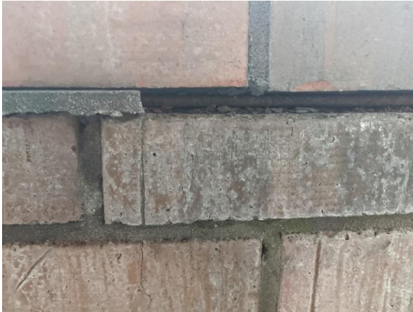
Kuva 14: Irronnut tiilisauma
