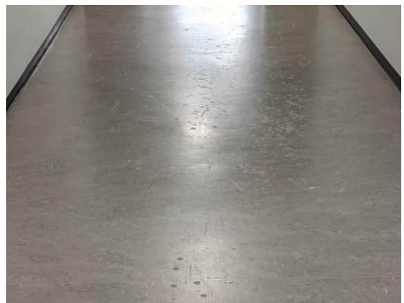
Kuva 31: Värjäytymät muovimatton pinnassa
