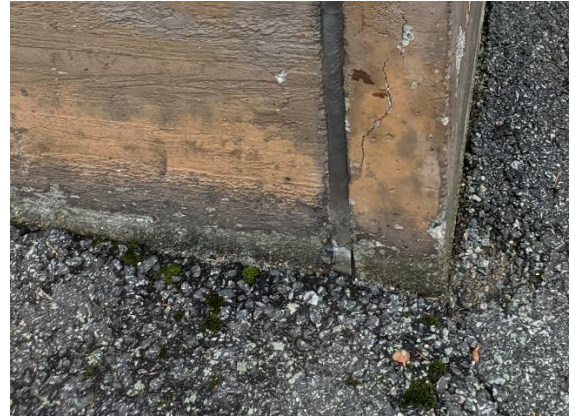
Kuva 5: Alapohjan halkeamat kellarin käytävällä Kuva 6: Asfaltin maaraja epätiivis
