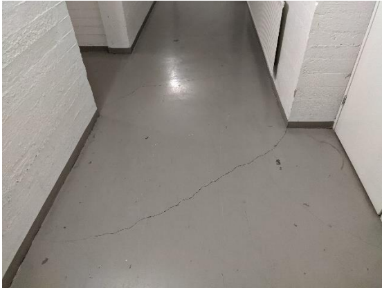
Kuva 5: Alapohjan halkeamat kellarin käytävällä Kuva 6: Asfaltin maaraja epätiivis
