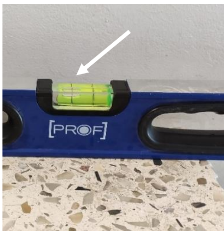
Kuva 11: Kallistunut porraskelma
