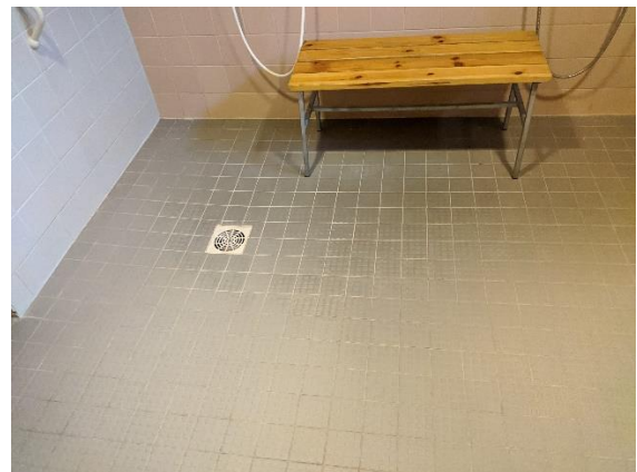
Kuva 33: Yhteisten tilojen pesuhuoneen lattia
