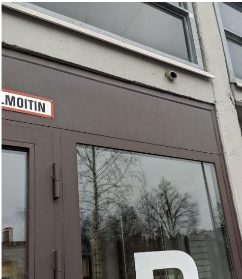
Kuva 18: Pääoven puuttuva lippa
