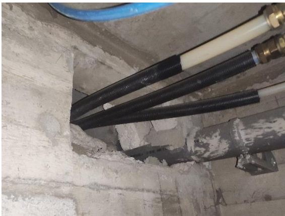
Kuva 39: Suora yhteys putkikanaalista hormiin
