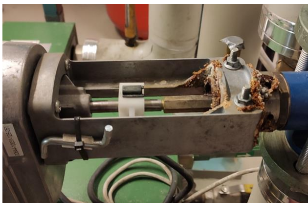
Kuva 36: Lämmönjakolaitteen moottoriventtiili
