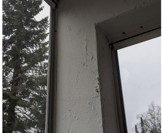
Kuva 15: Merkkejä kosteusrasituksesta
