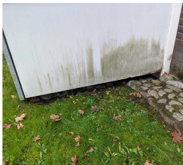
Kuva 21: Vaurioitunut rakennuslevy
