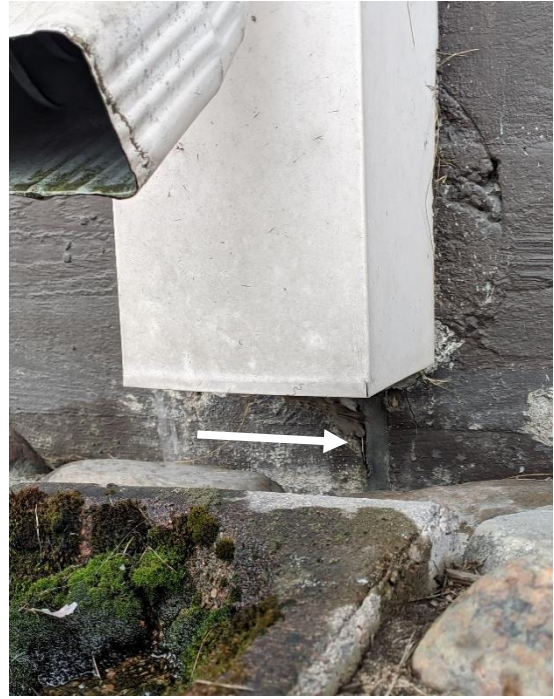
Kuva 4: Sokkelin elementtisaumat
