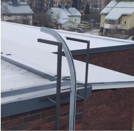
Kuva 23: Jälkiasennetun nousukiskon yläpää
