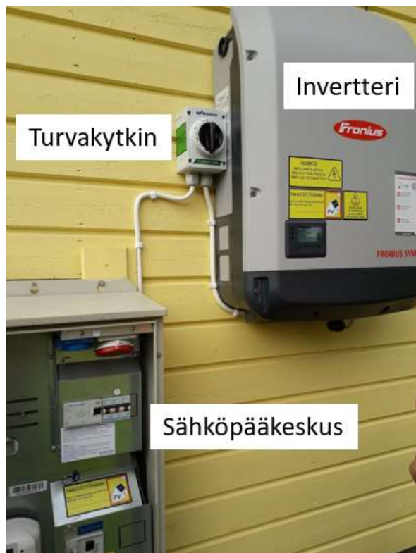
Kuva 13. Esimerkki AC-puolen sähköistä, varoitustarroista ja invertteristä (Tony Viitaniemi 2021)
