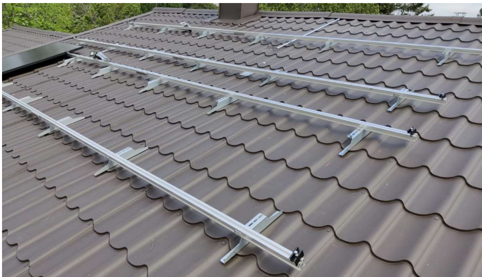
Kuva 10. Esimerkki kiskojen asennuksesta. (Tony Viitaniemi. 2021)
