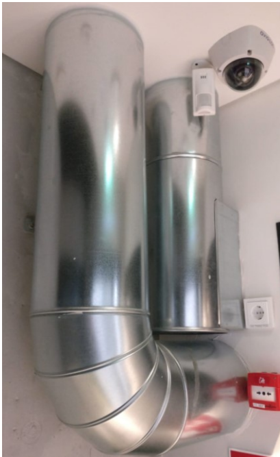
Kuva 4. Paloeristetty kanava, joka on pellitetty.
