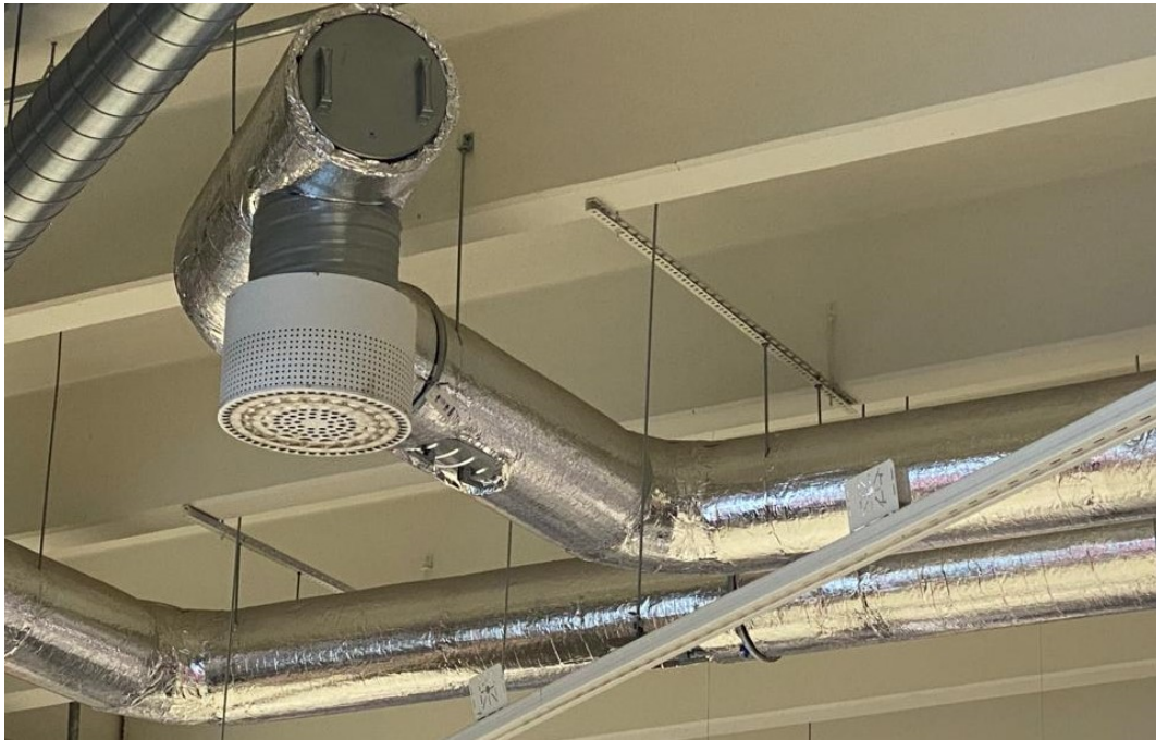
Kuva 13. Esimerkkikohteen tuloilmakanavan lämmöneristeratkaisu.
