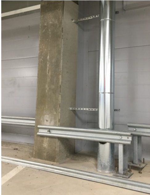
Kuva 8. Parkkihallissa sijaitseva kanava, joka on kolarisuojauskaiteella.
