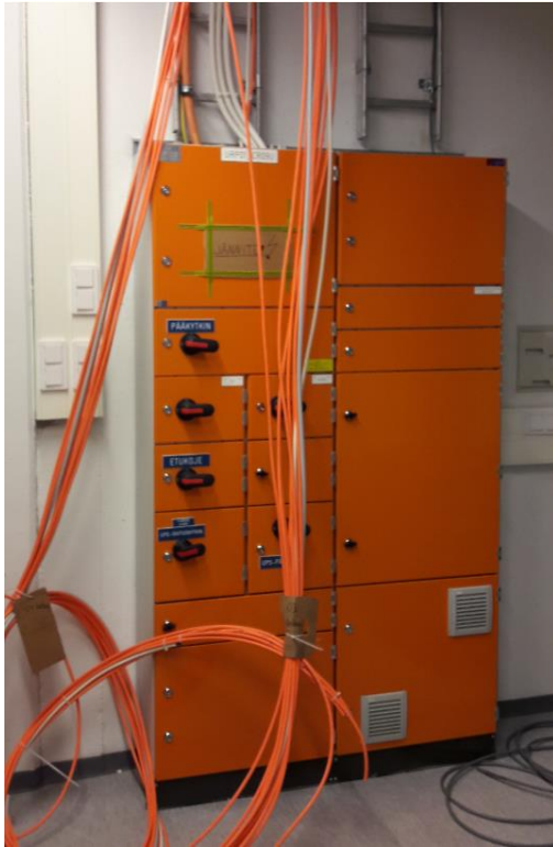
Kuva 10. UPS-käyttöön tarkoitettu keskus. RAL-sävy 2017.
