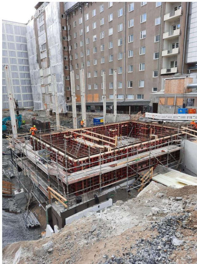
KUVA 4. Kasettimuottijärjestelmä asennettuna mallikohteessa (Häyrinen 2020)
