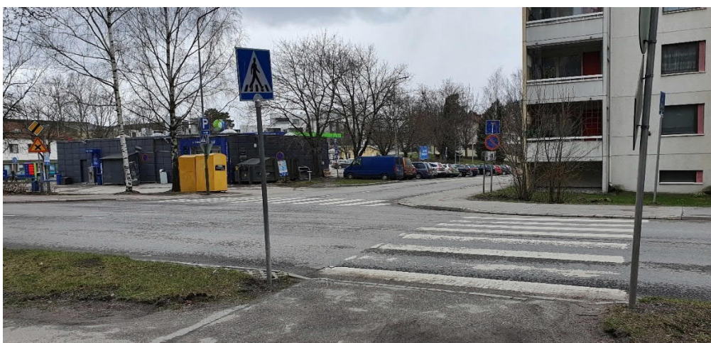
KUVA 21. Porvoonkatu Sahankatu risteysalue
