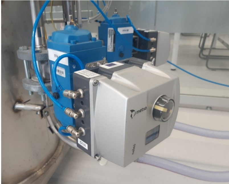
KUVA 16. Säästöventtiili, toimilaitte ja asennoitin
